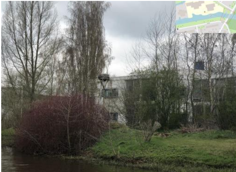
Figuur 2 bezet ooievaarsnest op circa 60 meter afstand van de te vervangen brug
