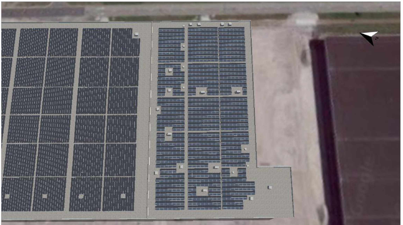
Afbeelding: 3. Modulevlak - Dak B-Module Area West
