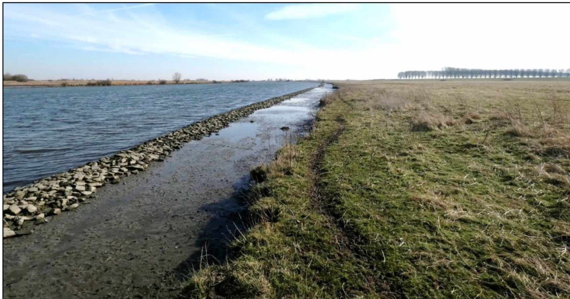
Figuur 13: De oever aan het westelijke gedeelte is kaal en onbegroeid. Voor de oever ligt een stenen rij die als golfbreker fungeert om afkalving tegen te gaan.
