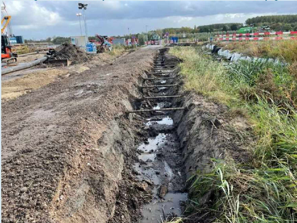
Foto 02: gesaneerde zuidelijke berm tussen de ankers 3-11-2021 oostelijk gericht
