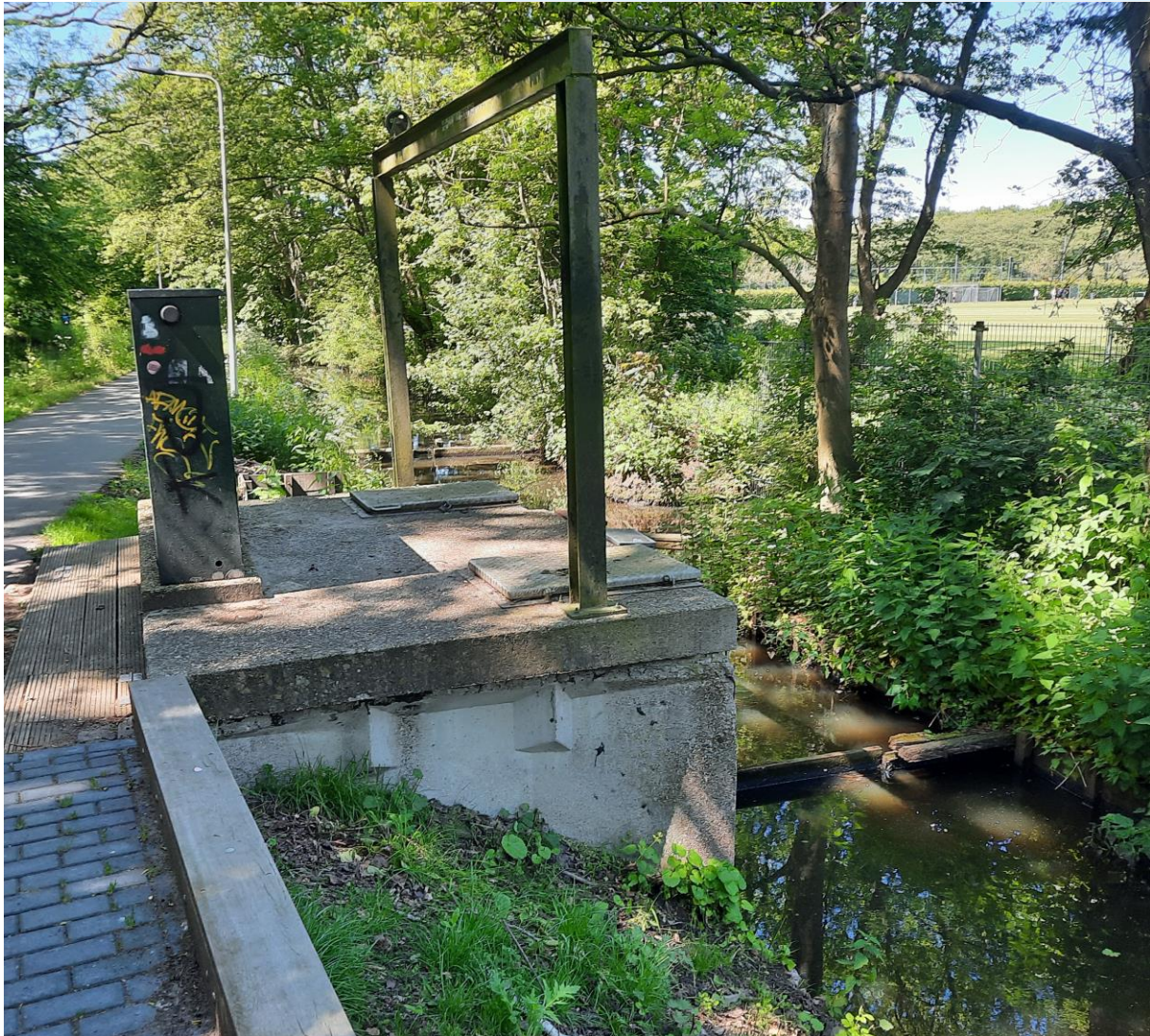
Afbeelding 3 Poldergemaal Groene Maredijk II – huidige situatie
