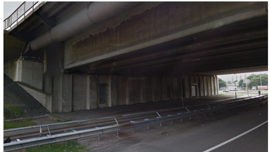
Het zuidelijke landhoofd gezien richting het westen. Google Maps 2018.
