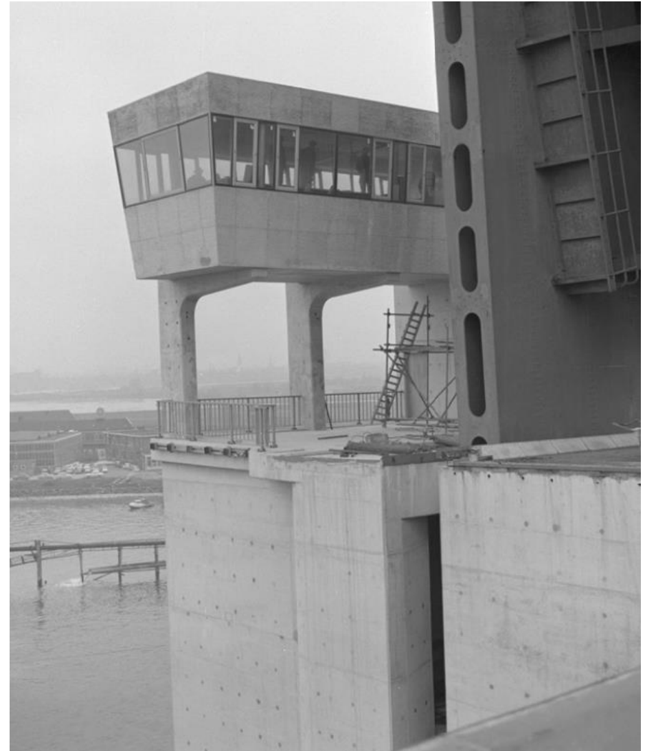
Zicht op het bedieningshuis met besturingsruimte in voorgespannen beton tijdens de bouw van de basculepijler. De besturingsruimte was op betonnen staanders gesitueerd zodat er goed zicht was over het wegdek en de rivier. SAR beeldbank, nr. 4121-7320-1.
