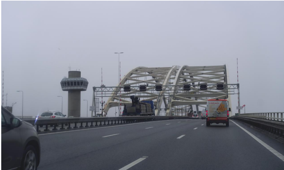
Zicht op de noordelijke oprit richting de westelijke brug uit 1990 ter hoogte van het basculedeel.
