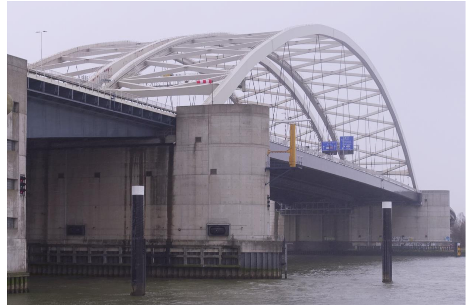
Zicht op de twee rivierpijlers uit 1990. Ook hier is een betonnen opbouw gemaakt op de uiteinden van de pijlers.
