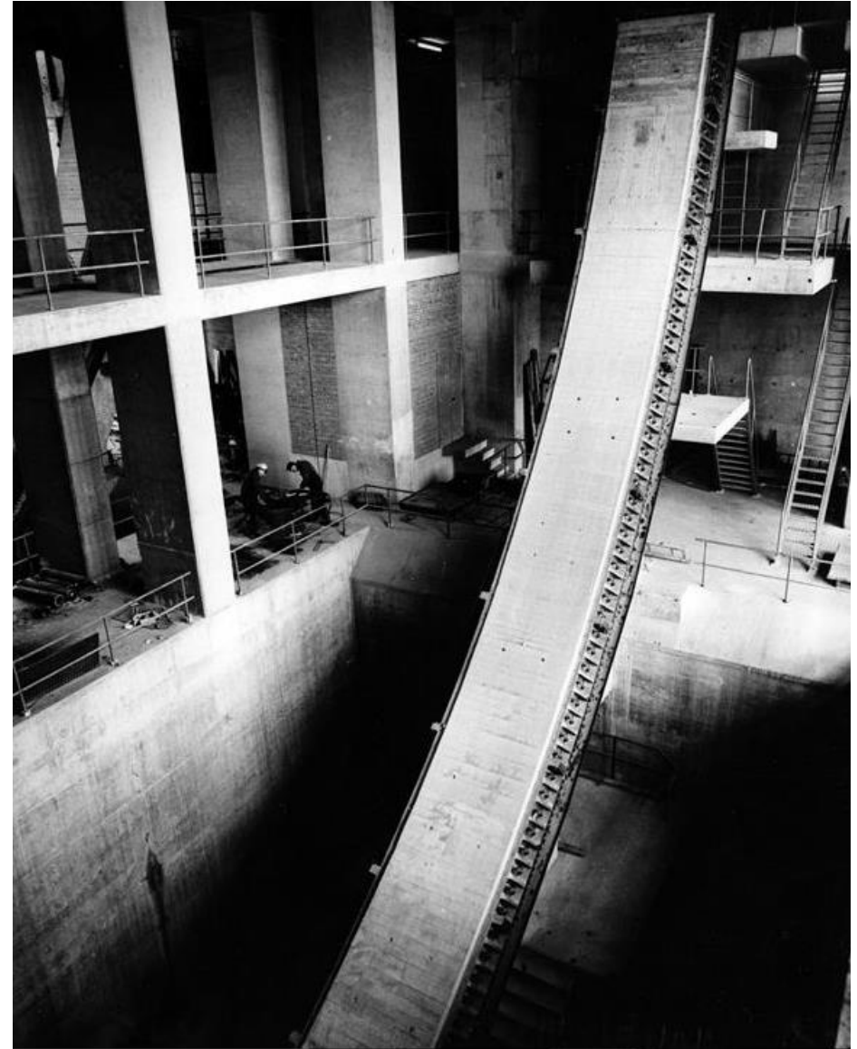
De basculepijler is ingericht met een tandbaan per val. RWS beeldbank, Auke Leen, nr. BOB-087.
