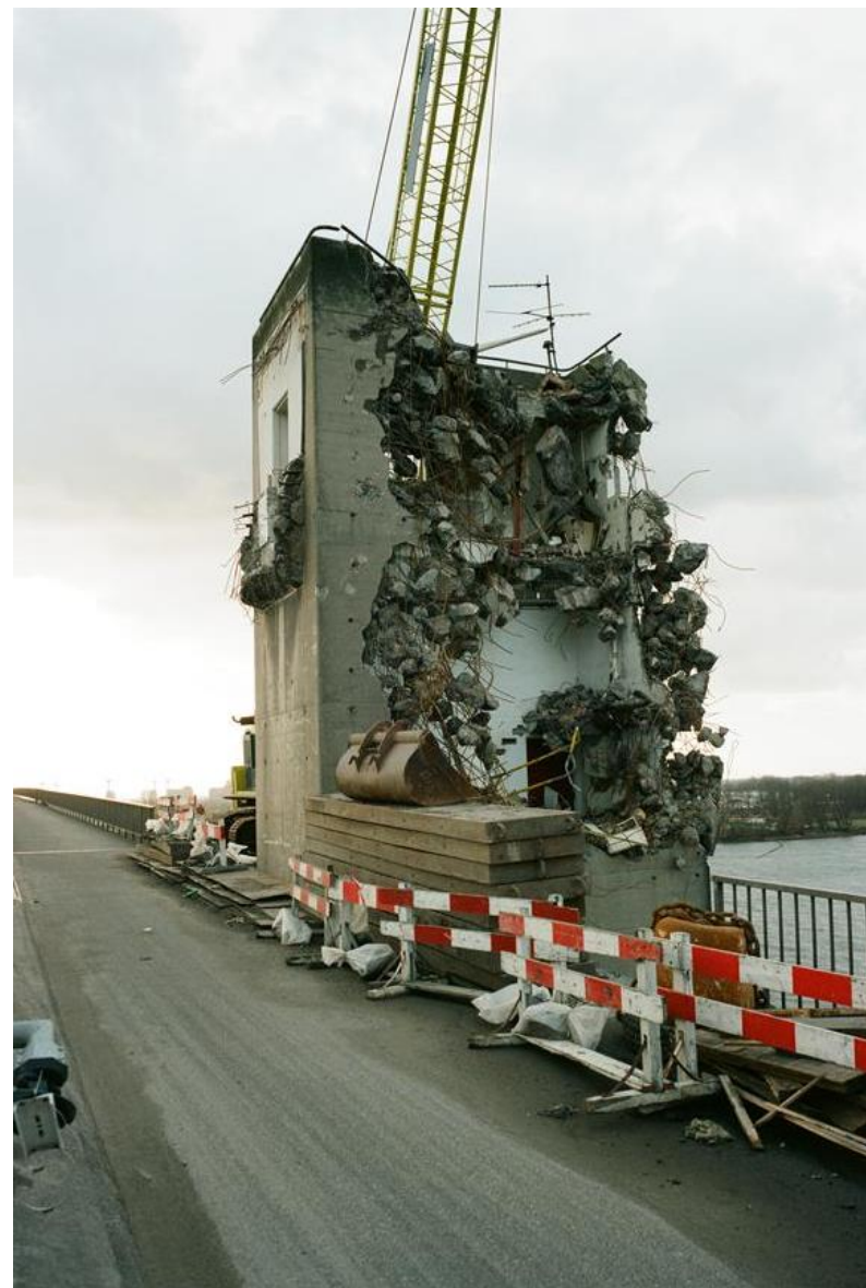
Voor de verbreding van de brug is het bedieningshuis gesloopt. RWS beeldbank, nr. 2214-016.
