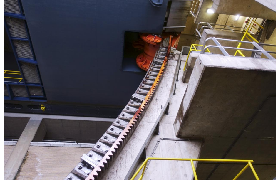
Detail van de tandradbaan en de betonnen bordessen op de verschillende niveaus.
