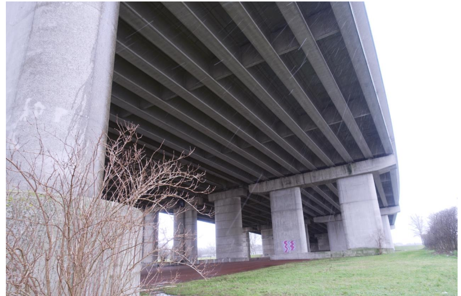
Zicht op de liggers van de zuidelijke aanbruggen.
