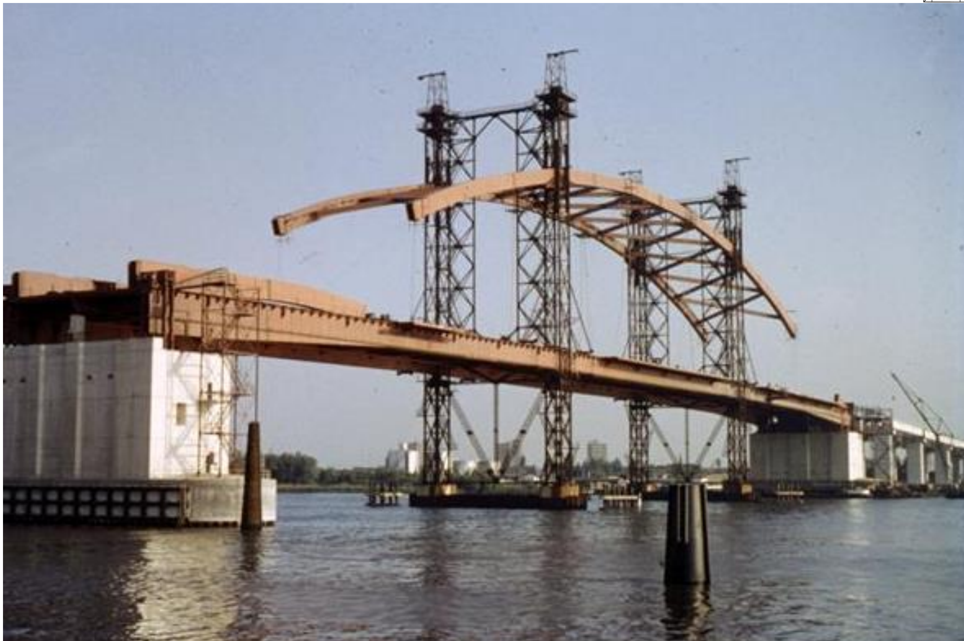
De bouw van de brug is in een vergevorderd stadium waarbij de basculebrug en de aanbruggen grotendeels gereed zijn. De boog is nog niet afgerond en wordt tussen de hulppijlers opgebouwd. RWS beeldbank, Auke Leen, nr. BOB-084.
