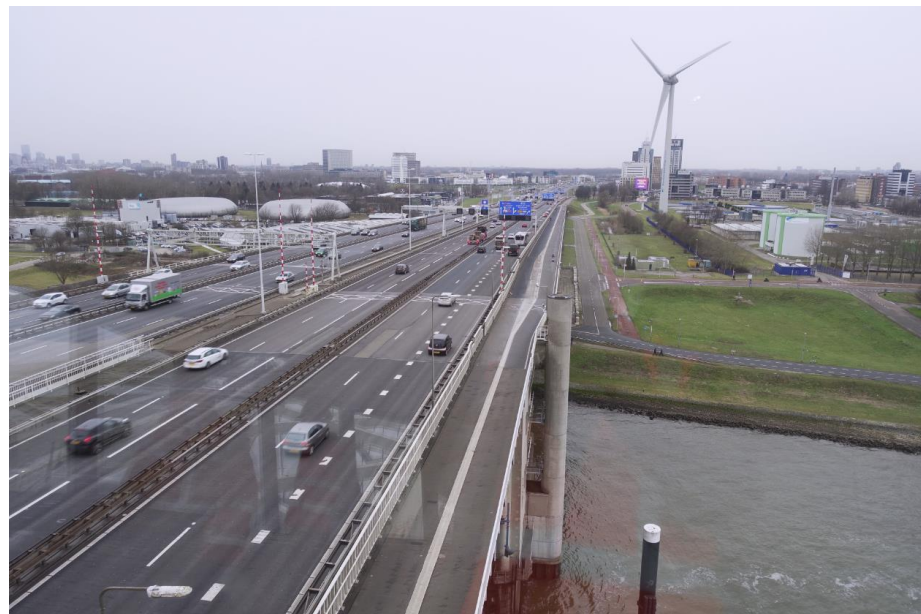
Zicht op de A16 richting het noorden vanuit het bedieningshuis.
