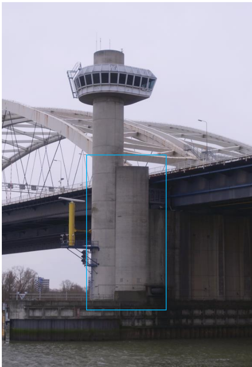
Naast het nieuwe bedieningshuis is de noordelijke pijler in 1990 ook voorzien van een betonnen uitbouw (blauwe omlijning).
