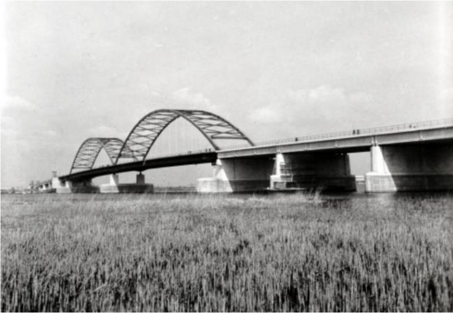
Foto uit 1961 van de Merwedebrug bij Gorinchem vlak na oplevering. NA beeldbank, coll. Spaarnestad.
