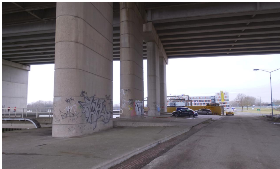
Aan de noordzijde is de historische Schaardijk gesitueerd onder de brug.
