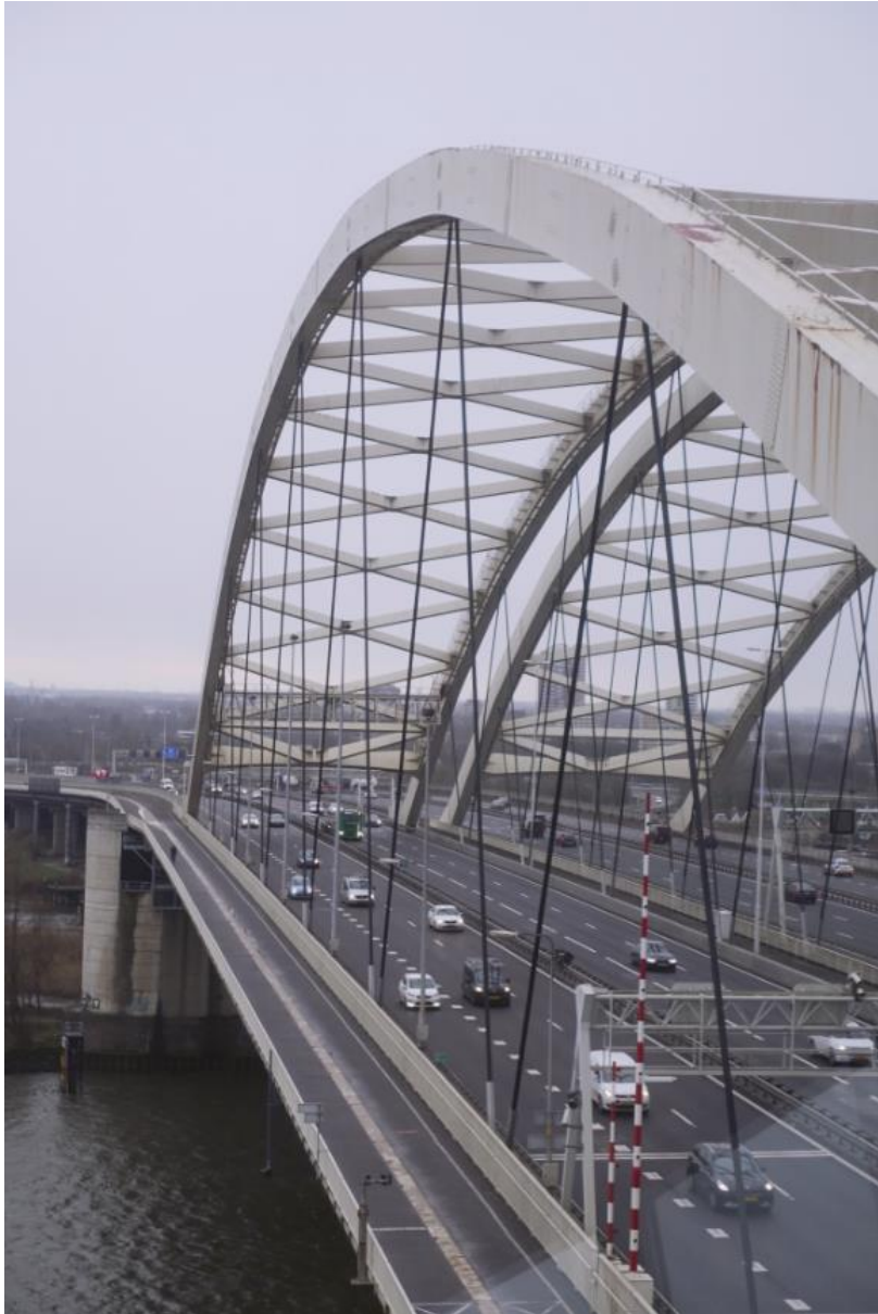
De weghelft richting het noorden gezien vanuit het bedieningshuis. Uiterst links is het tweebaans fietspad zichtbaar.
