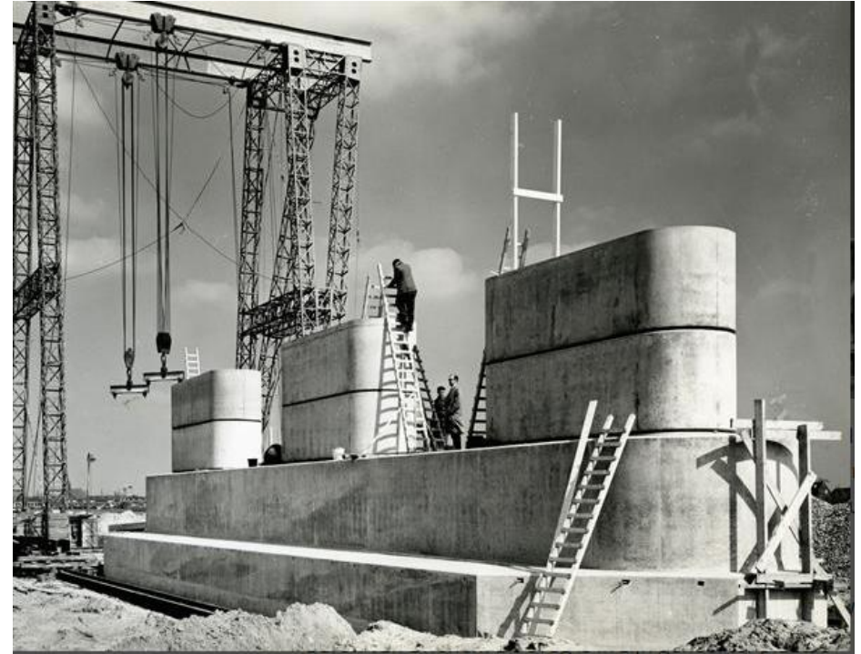
De bouw van de drie pijlers van een van de aanbruggen in 1959. RWS beeldbank, Afdeling Multimedia, nr. 23856-001.
