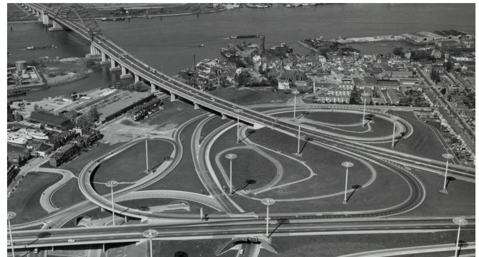
De zuidelijke aanbruggen met aansluitend knooppunt IJsselmonde. Het gebied werd verlicht door kenmerkende lantaarnpalen met schotelverlichting. NA beeldbank, nr 123-0893.
