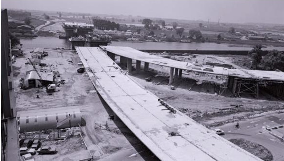
Zicht op de oprit naar de brug over de Nederrijn bij Arnhem tijdens de bouw in 1976, gebouwd in lichtbeton en volgens de vrije uitbouwmethode. RWS beeldbank, Afdeling Multimedia Rijkswaterstaat, nr. 24919-009.
