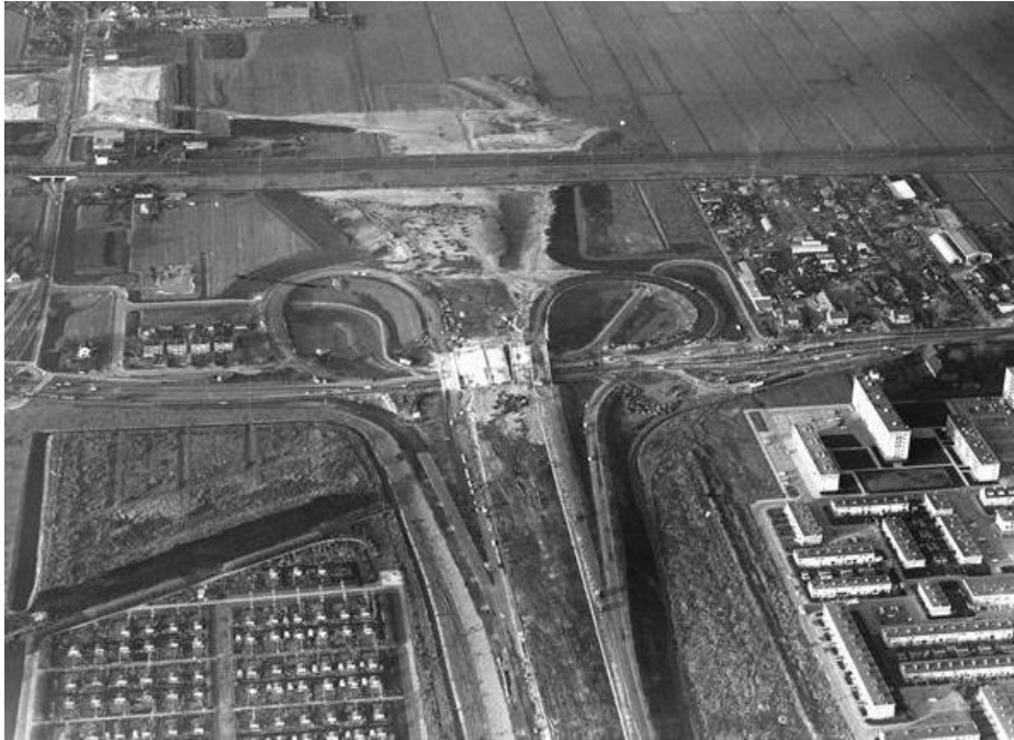
Aanleg van de rijksweg 16 bij het knooppunt met de huidige Bosweg in Rotterdam. RWS beeldbank, nr. Ruit-04.
