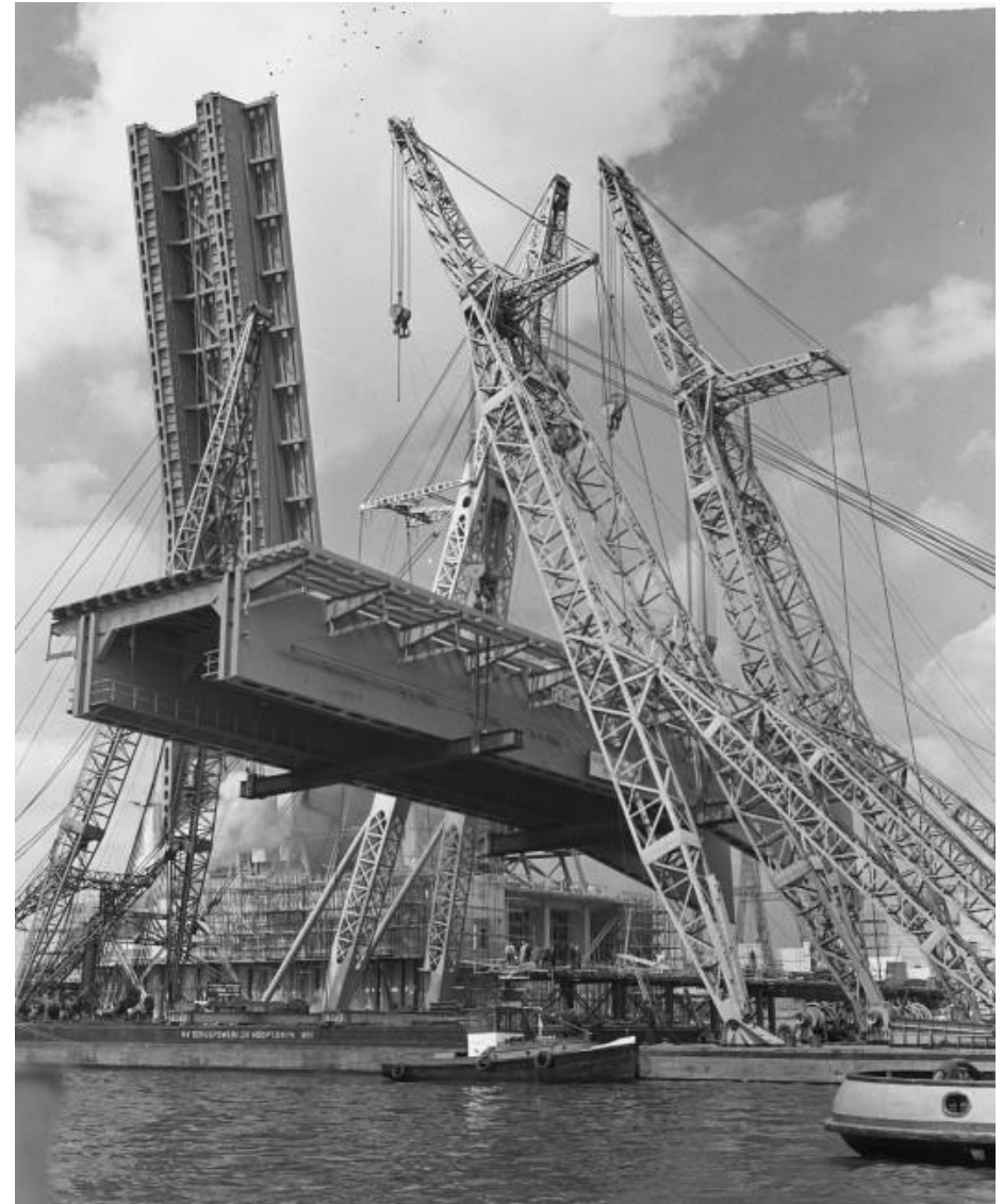
Het voorste deel van het tweede val wordt ingehesen. Op de achtergrond is het eerste val in open toestand zichtbaar. NA beeldbank, nr. 915-1863.
