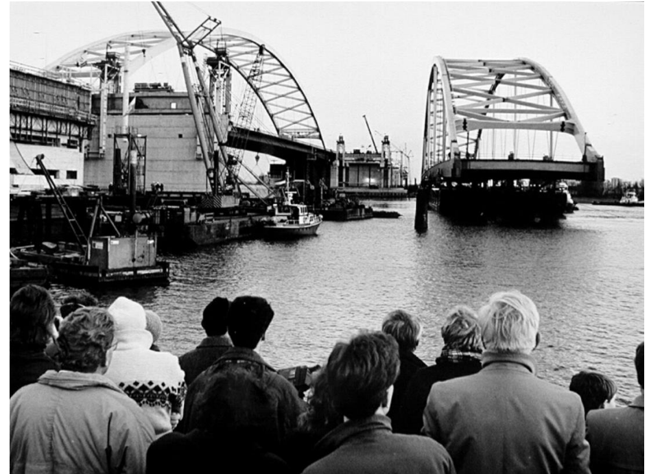
Het invaren van de tweede brug in 1989. SAR beeldbank, nr. 4282_2000-967, fotograaf: R. Dijkstra.
