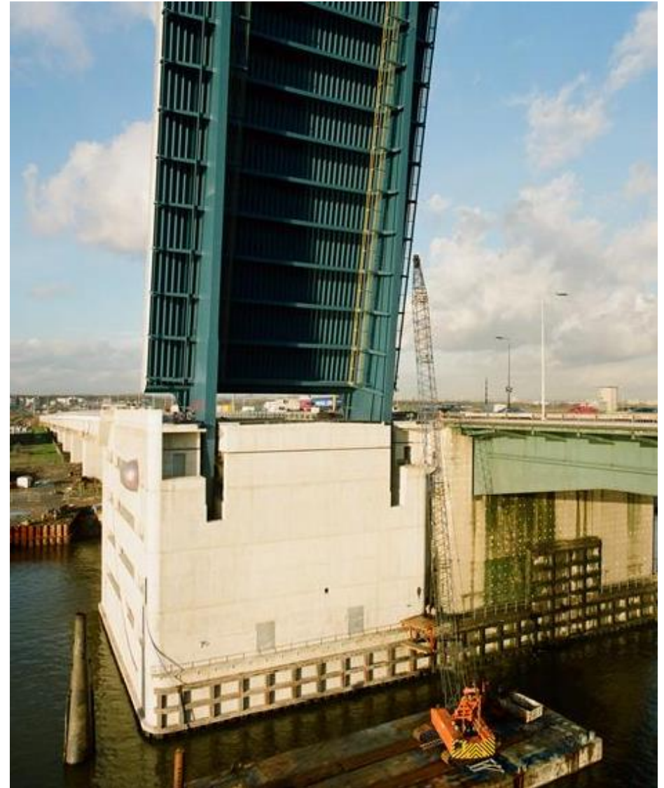
Het val van de nieuwe basculebrug in open toestand. RWS beeldbank, nr. 814-019, fotograaf: Rens Jacobs.
