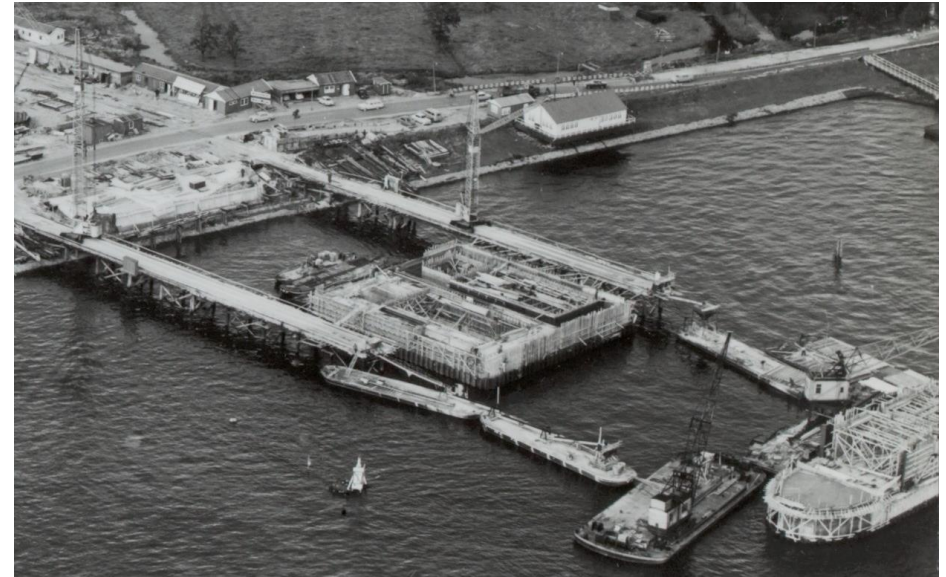
De bouw van de in het water liggende basculepijler vordert gestaag. NA beeldbank, nr. 123-0884.
