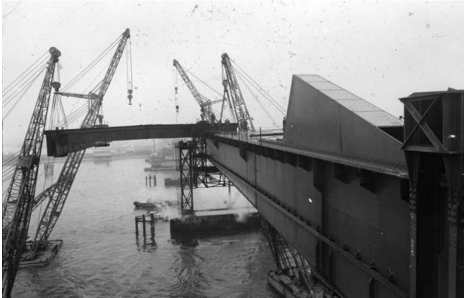
De liggers van de hoofoverspanning wordt ingehesen. RWS beeldbank, Auke Leen, nr. BOB-038.
