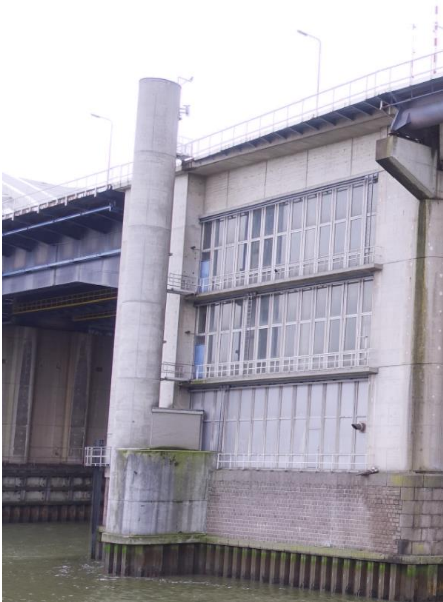
De oostgevel van de basculepijler uit 1965. De betonnen liftkoker is op een in 1990 gemaakt uitbouw geplaatst.
