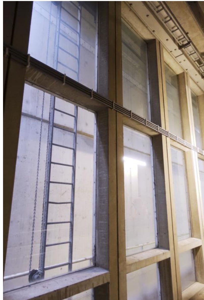
De westgevel van de basculepijler uit 1965 heeft ook nog de oude lichtpui.
