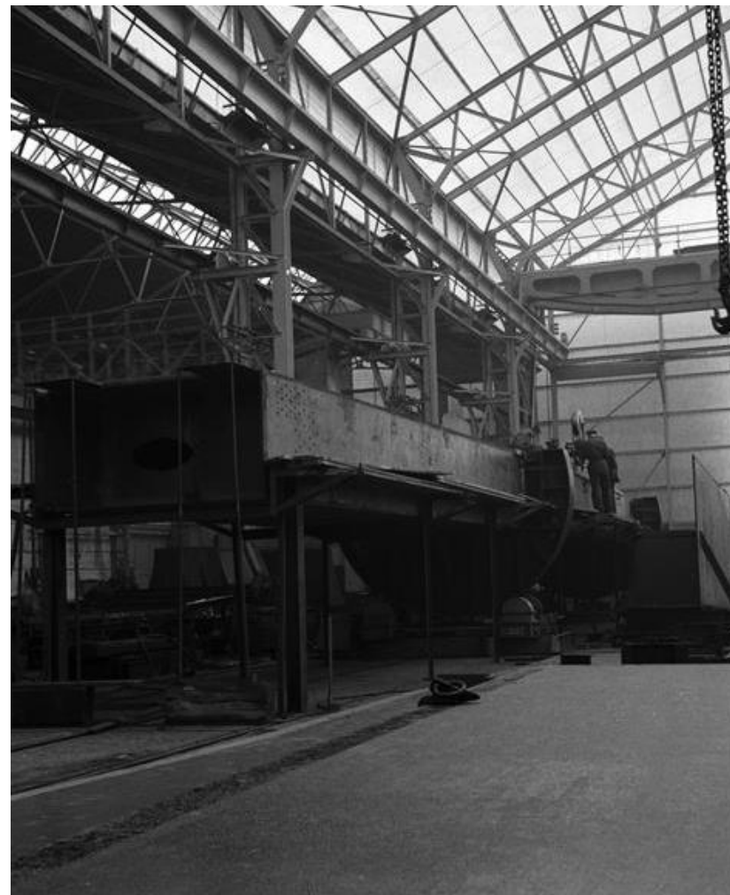
De verschillende onderdelen van de boog van de Van Brienenoordbrug zijn in de werkplaats van Braat samengesteld en in delen verscheept naar de bouwplaats. Daar is de boog ter plekke in elkaar gezet. RWS beeldbank, Afdeling Multimedia, nr. 23865-027.
