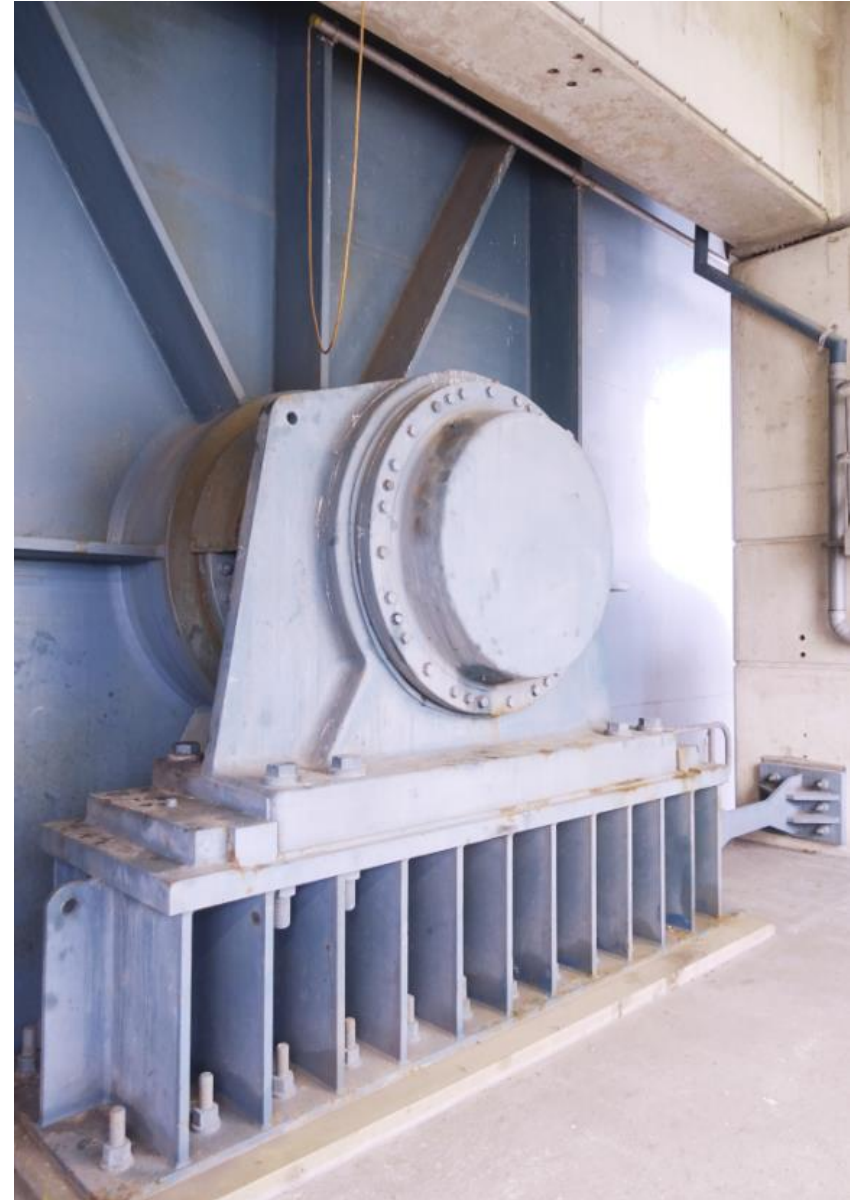
Zicht op de bevestiging van de draaia's bij de klep uit 1990.
