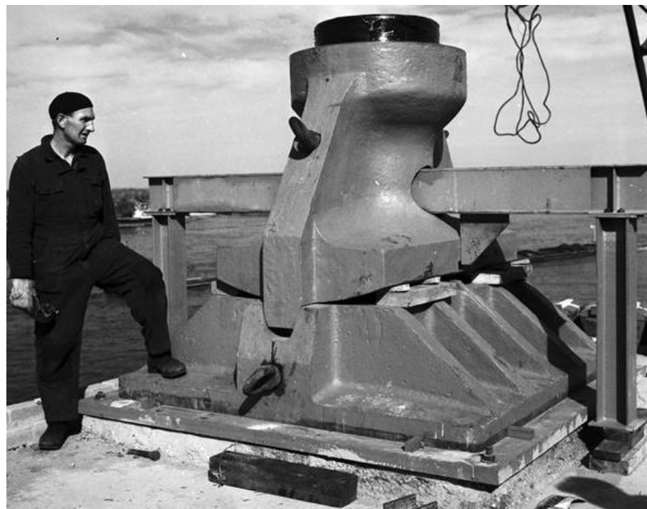
Zicht op de oplegging van de hoofdligger bij de overspanning. RWS beeldbank, Auke Leen, nr. BOB-048.
