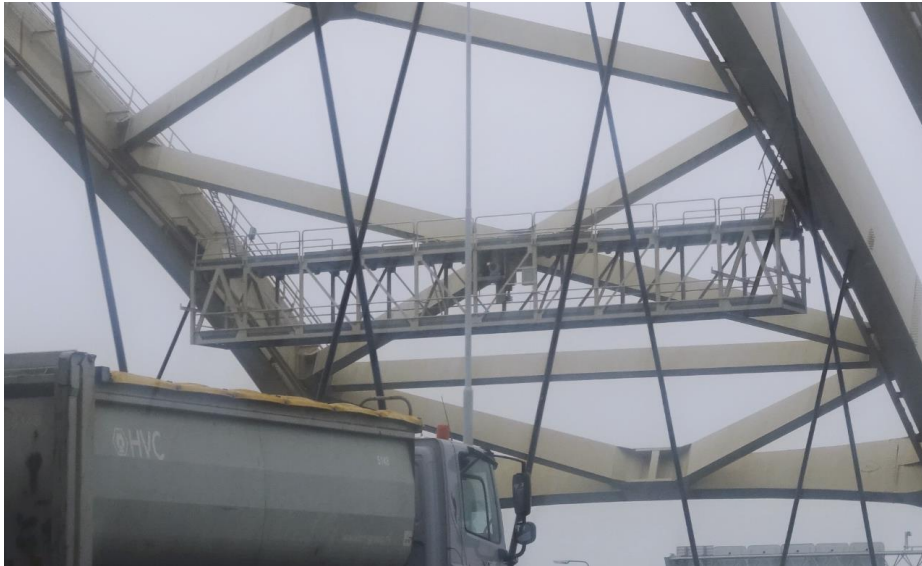
Aan de binnenzijde van de boog hangt een verfwagen van stalen vakwerkliggers uit 1965.
