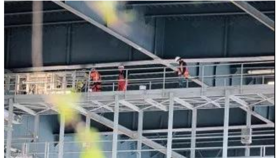
Detail van de dragers van het rijdek bij de oude boogbrug. afb: 'Onderhoud aan de onderzijde van Brienenoordbrug', op beverwaardigheden.nl, 16 augustus 2018.
