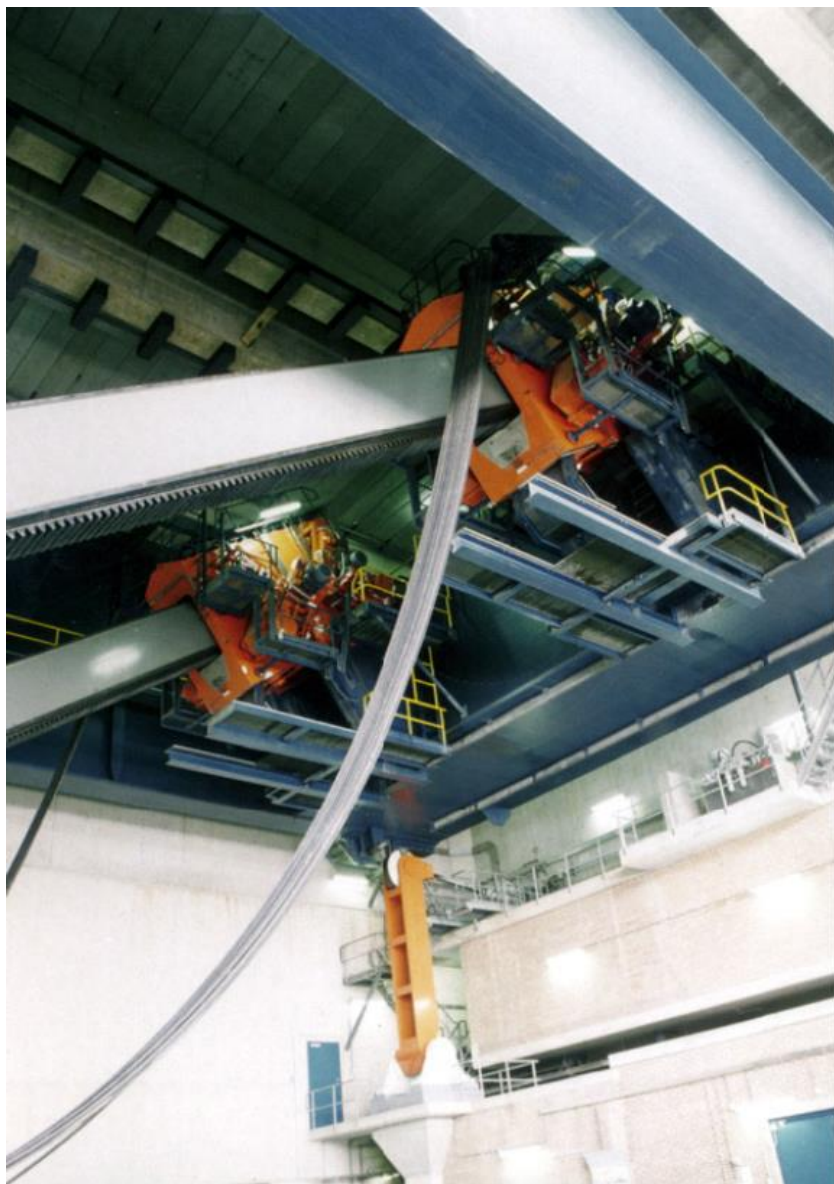
Zicht op de twee heugels die het val in beweging trekken in de nieuwe basculepijler. SAR beeldbank, nr. 4100_1994-1218, fotograaf: T. de Rooij.
