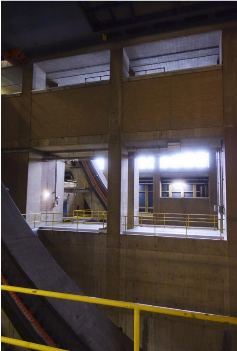
Tussen de twee open ruimtes in de oude basculepijler loopt een smalle gang.
