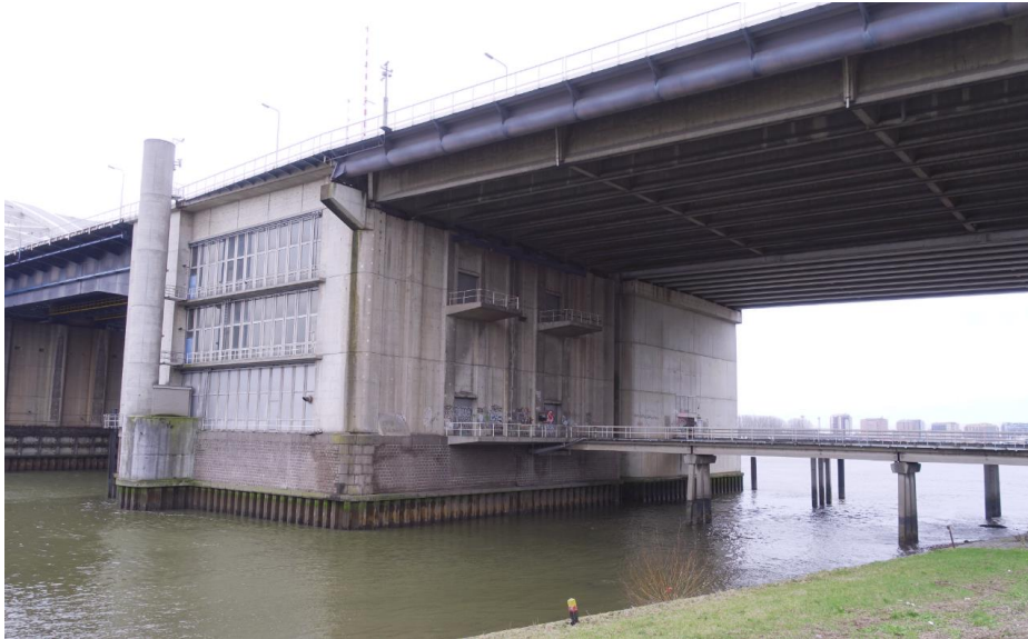
De basculepijlers uit 1965 en 1990 staan in het water en zijn per brug vanaf de noordoever bereikbaar.
