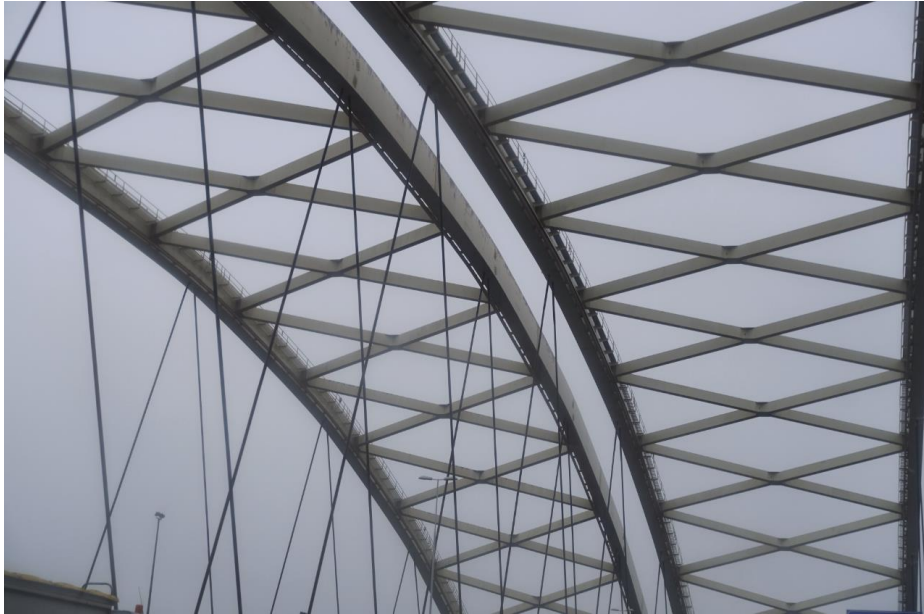
De twee bogen gezien vanaf de A16 richting het zuiden, met links de boog uit 1965. De tuien zijn mogelijk ooit vervangen.
