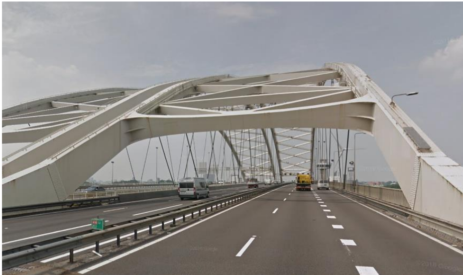
Bij het eindportaal van de boog uit 1965 is een K-verband gemaakt. Google Maps 2018.
