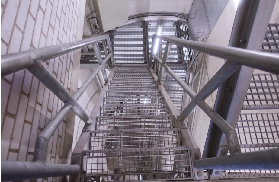
In de koker van het bedieningshuis is een trappenhuis gemaakt van bordestrappen van gegalvaniseerd staal.
