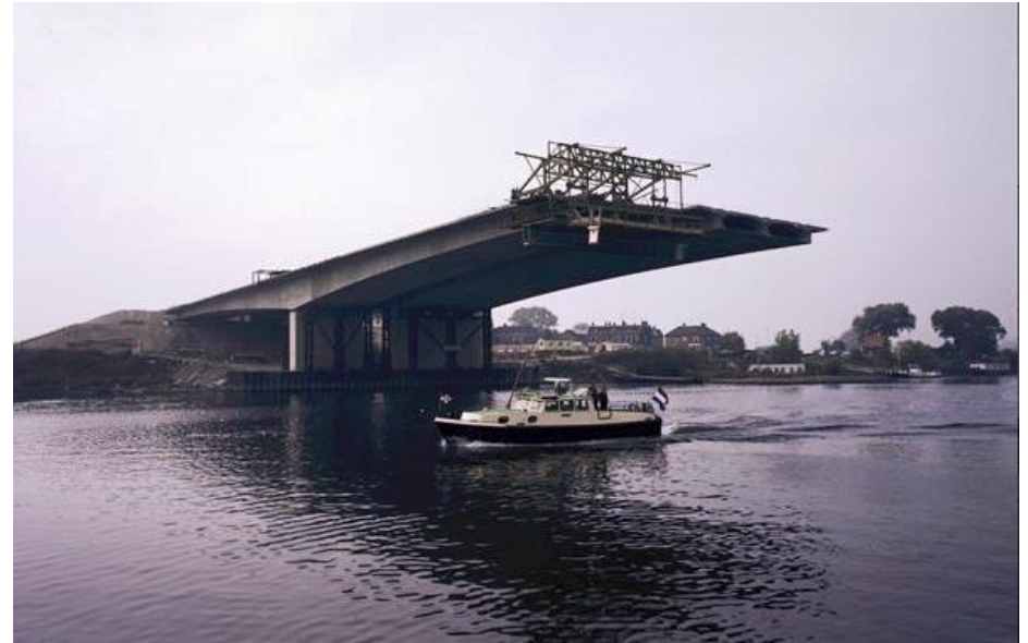
Zicht op de bouw in 1978 van de brug over de Nederrijn bij Arnhem in lichtbeton. RWS beeldbank, Afdeling Multimedia Rijkswaterstaat, nr. 23697-014.
