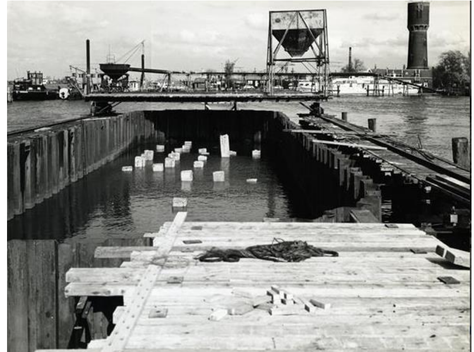
De bouw van een van de rivierpijlers in 1961. RWS beeldbank, Afdeling Multimedia, nr. 23858-008.
