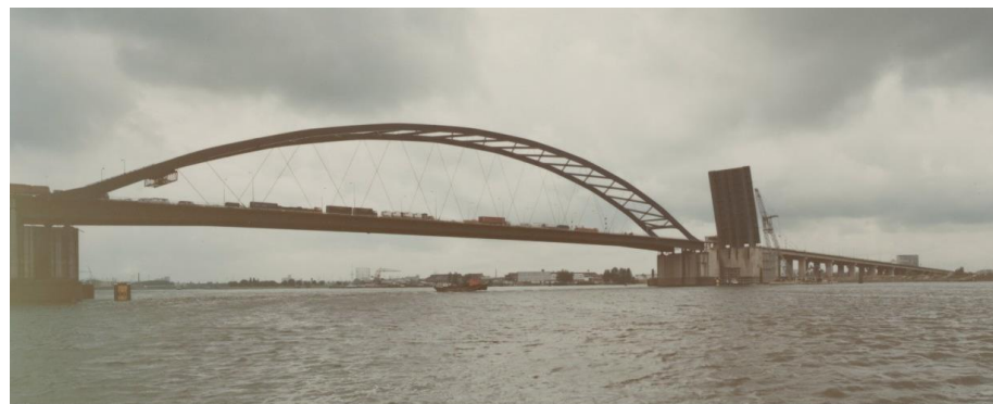
Zicht op de brug vanaf het water. De stalen onderdelen van de brug zijn groen geverfd. NA beeldbank, nr. 145-0853.
