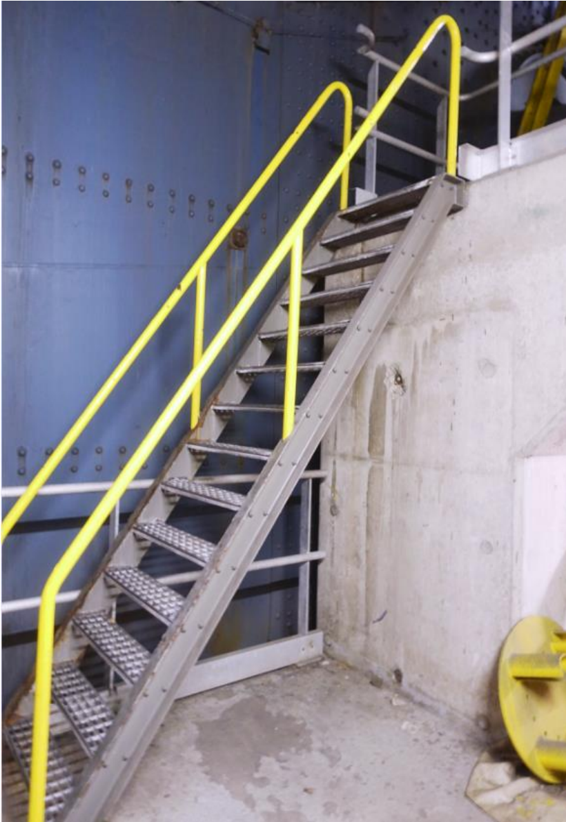
De verschillende niveaus in de pijler zijn via stalen en betonnen trappen met elkaar verbonden.
