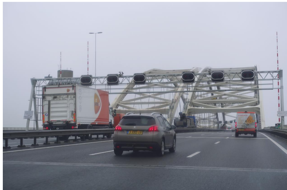
Zicht op de zes stroken (gescheiden door een vangrail) die de weghelft richting het zuiden vormen.
