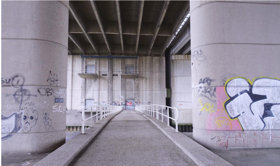
Zicht op de entree vanaf de noordoever naar de basculepijler uit 1965.
