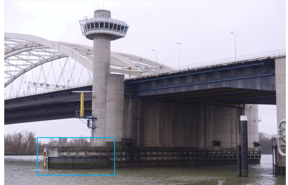
Zicht op de noordelijke rivierpijler van de boogbrug met bedieningshuis uit 1987. De pijler is ten behoeve van de bouw van het nieuwe bedieningshuis uitgebreid richting het oosten (blauwe omlijning).
