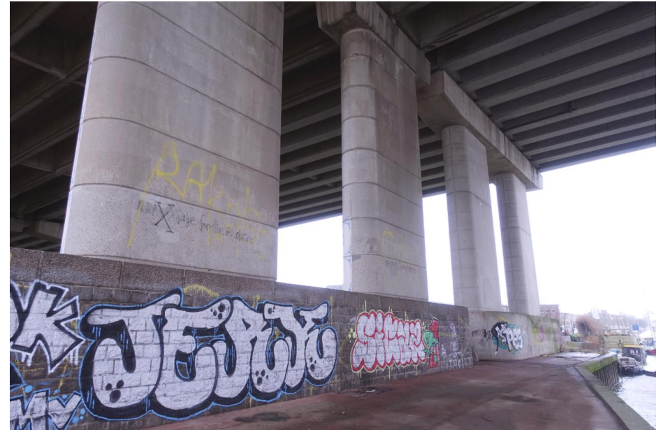
Het verschil in de opbouw van de onderbouw bij de pijlers uit 1965 (voorgond) met graniet en 1990 met kaal beton (achtergrond).
