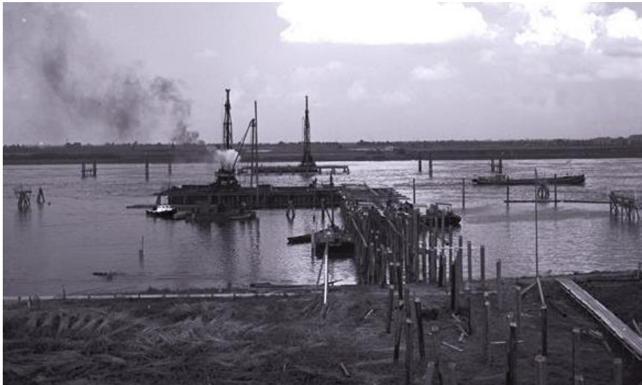
De bouw van de Merwedeburg tussen Gorinchem en Sleetwijk is in 1958 begonnen. RWS beeldbank nr. 24020-015.
