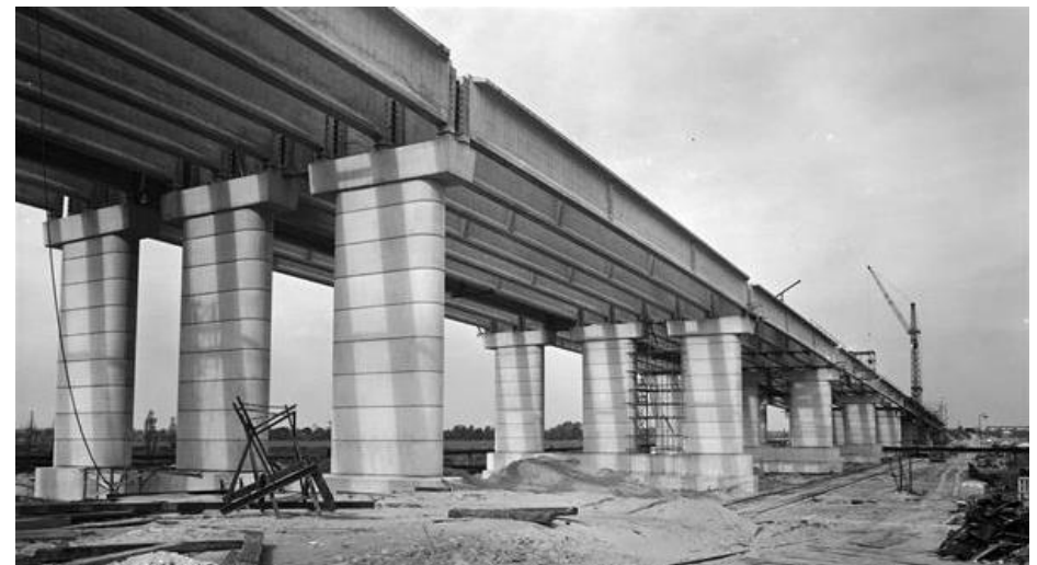
De constructie van de aanbruggen in voorgespannen beton. RWS beeldbank, Afdeling Multimedia, nr. 24475-006.
