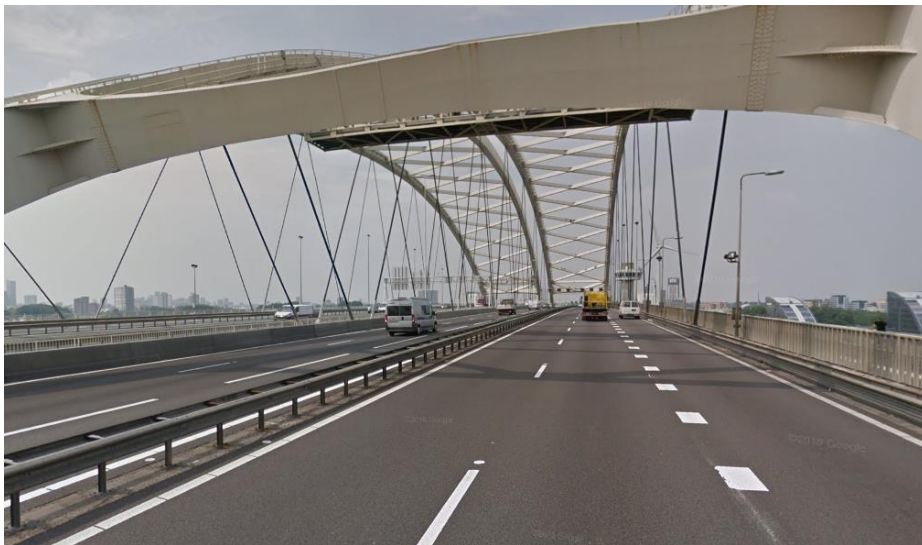
De twee weghelften richting het noorden, gescheiden door een vangrail. De meest rechter strook vormt de afrit van afslag 25. Google Maps 2018.
