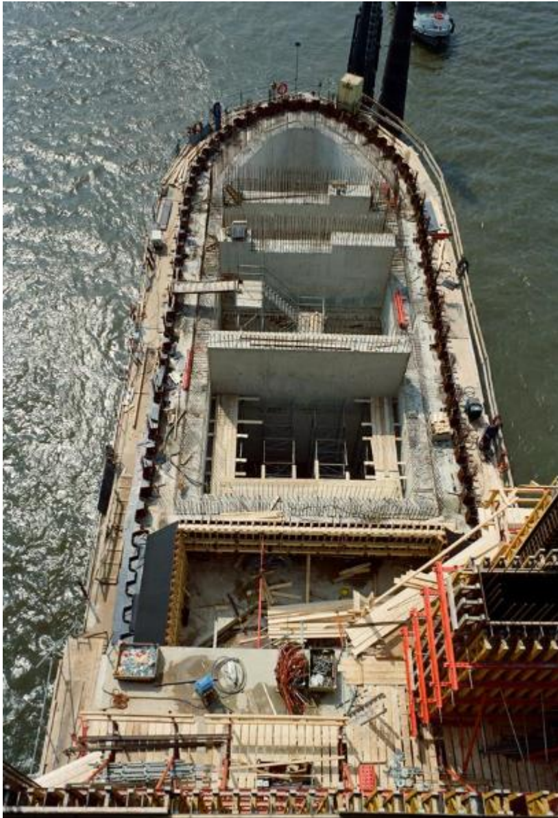
De holle binnenzijde van een van de rivierpijlers van de nieuwe brug. RWS beeldbank, Afdeling Multimedia, nr. 1539-045.
