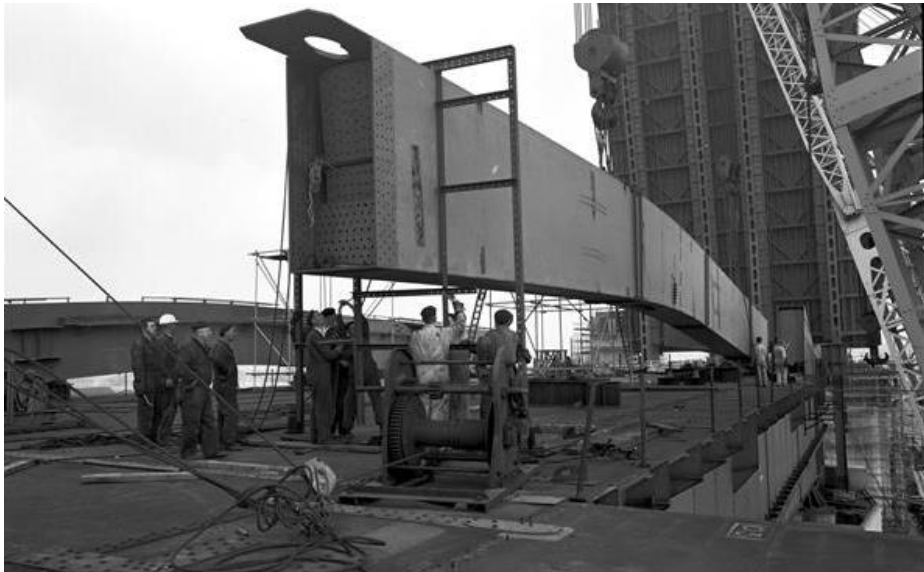
Een van de boogdelen wordt ingehesen. RWS beeldbank, Afdeling Multimedia, nr. 23910-024.
