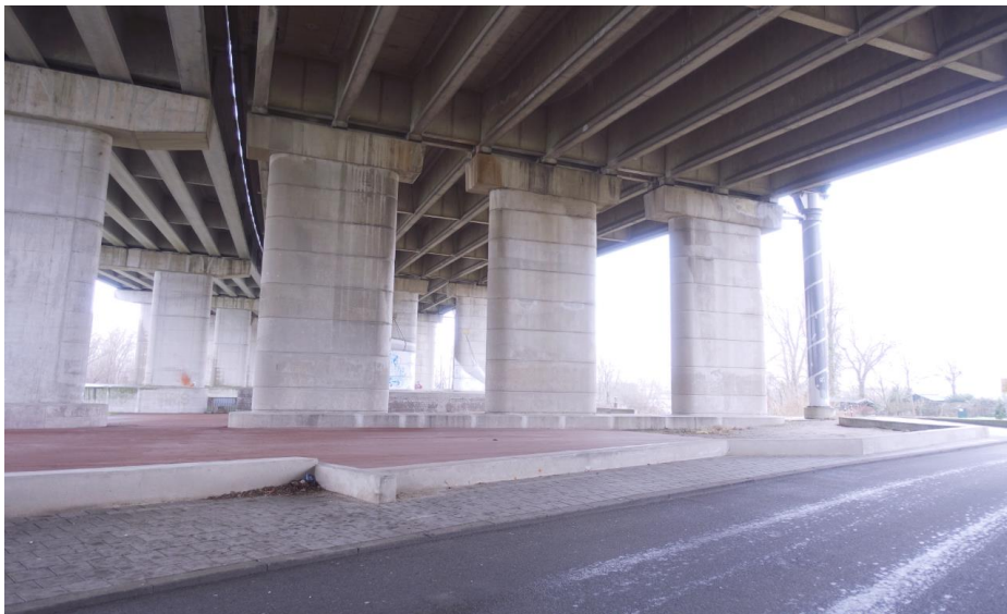
Zicht op de Bovenstraat die aan de zuidzijde onder de brug door gaat.
