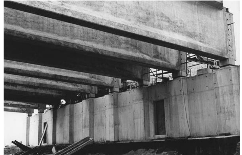
Zicht op de betonnen liggers van een aanbrug bij de aansluiting met een landhoofd. RWS beeldbank, Auke Leen, nr. BOB-085.
