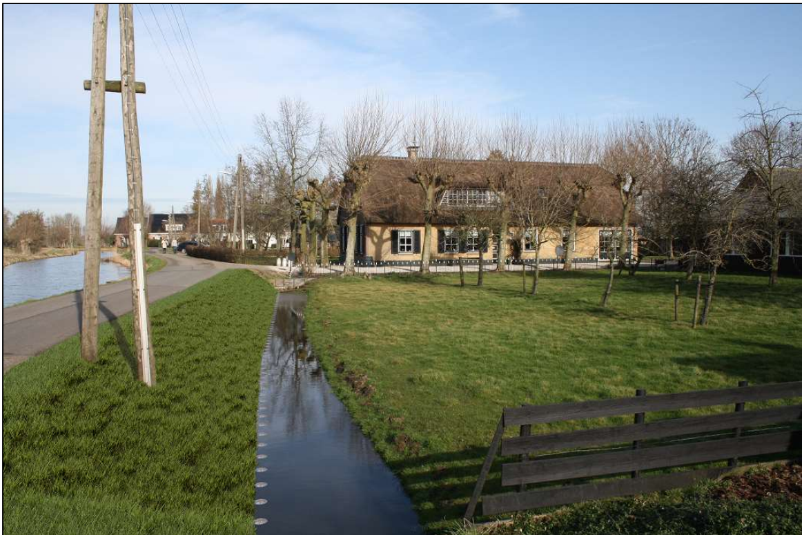
Figuur 6 Impressiebeeld na afronding van de werkzaamheden. Het binnentalud is breder geworden en de palen van het stabiliteitsscherm zijn gelijk met het waterpeil.
