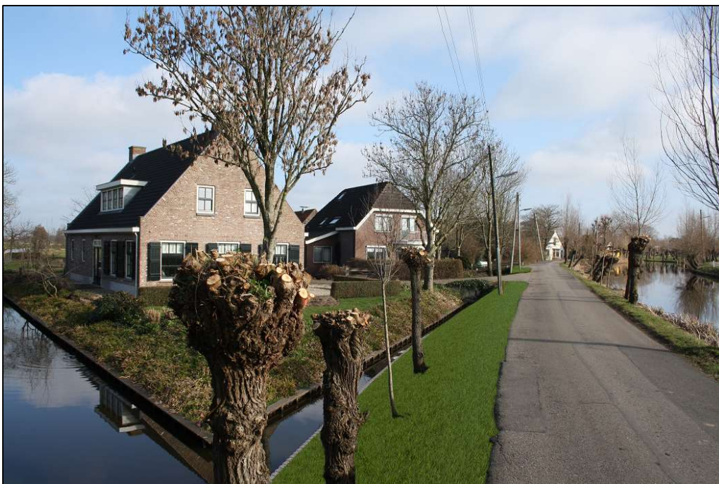
Figuur 9 Impressiebeeld na afronding van de werkzaamheden. Het binnentalud is verbreed en het stabiliteitsscherm is geplaatst. De palen steken 10 cm boven het waterpeil uit.
