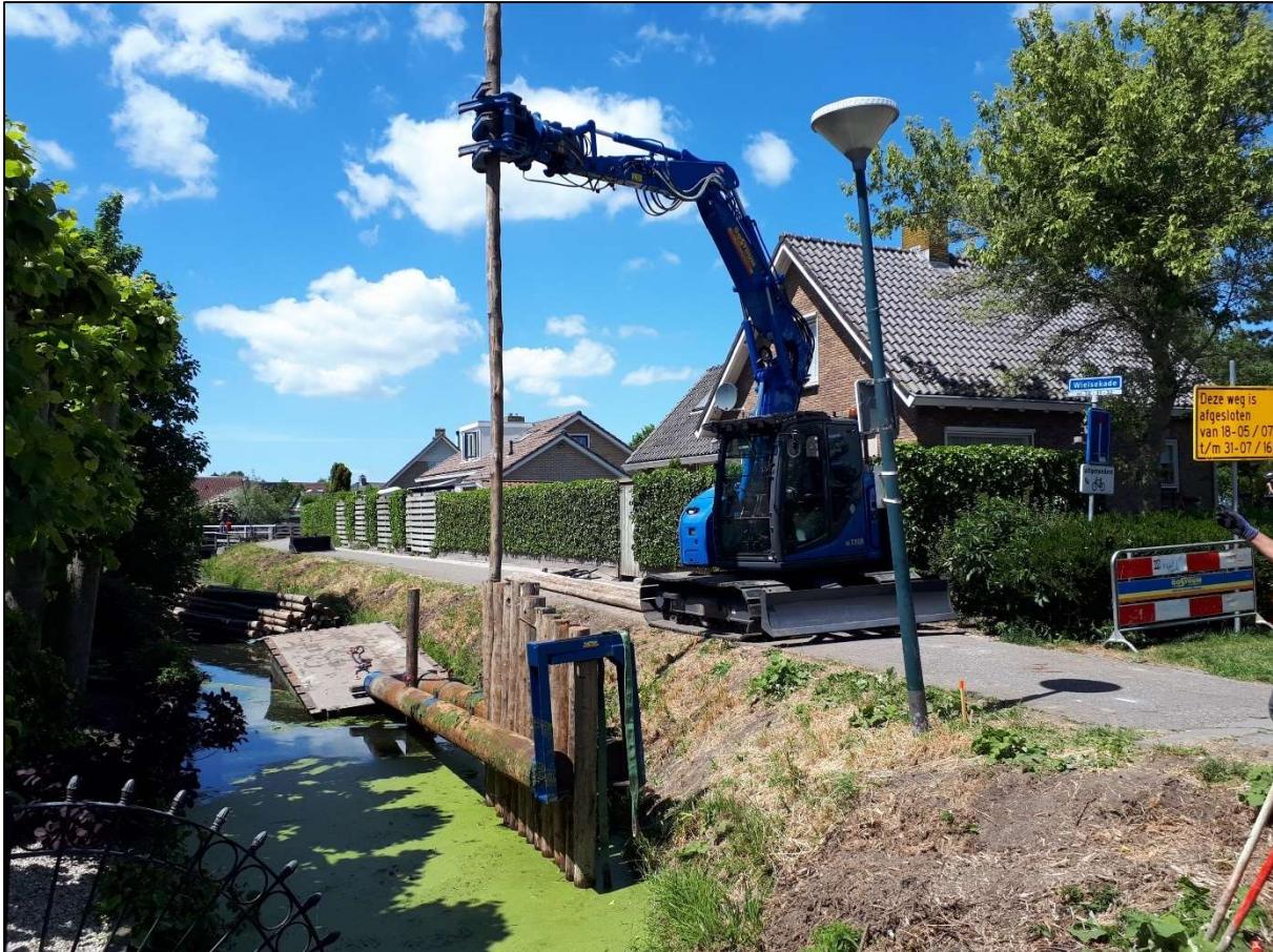
Figuur 15 Een aannemer aan het werk bij het vergelijkbare project kadeverbetering Lopikerwetering van HDSR.
