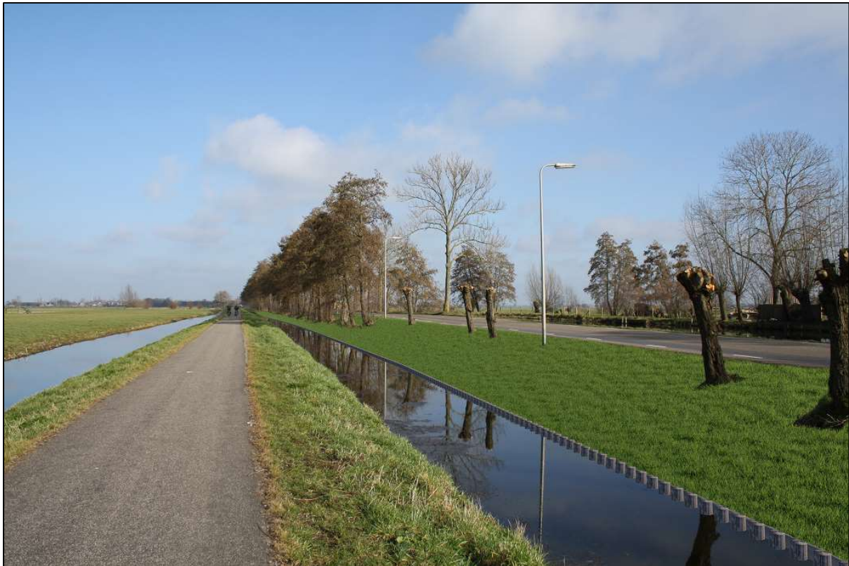
Figuur 11 Impressiebeeld na afronding van de werkzaamheden. Het binnentalud is verbreed en de palen van het stabiliteitsscherm steken 15 centimeter boven het waterpeil uit. De bomen worden tijdens het groot onderhoud van de gemeente teruggesnoeid naar knotbomen.
