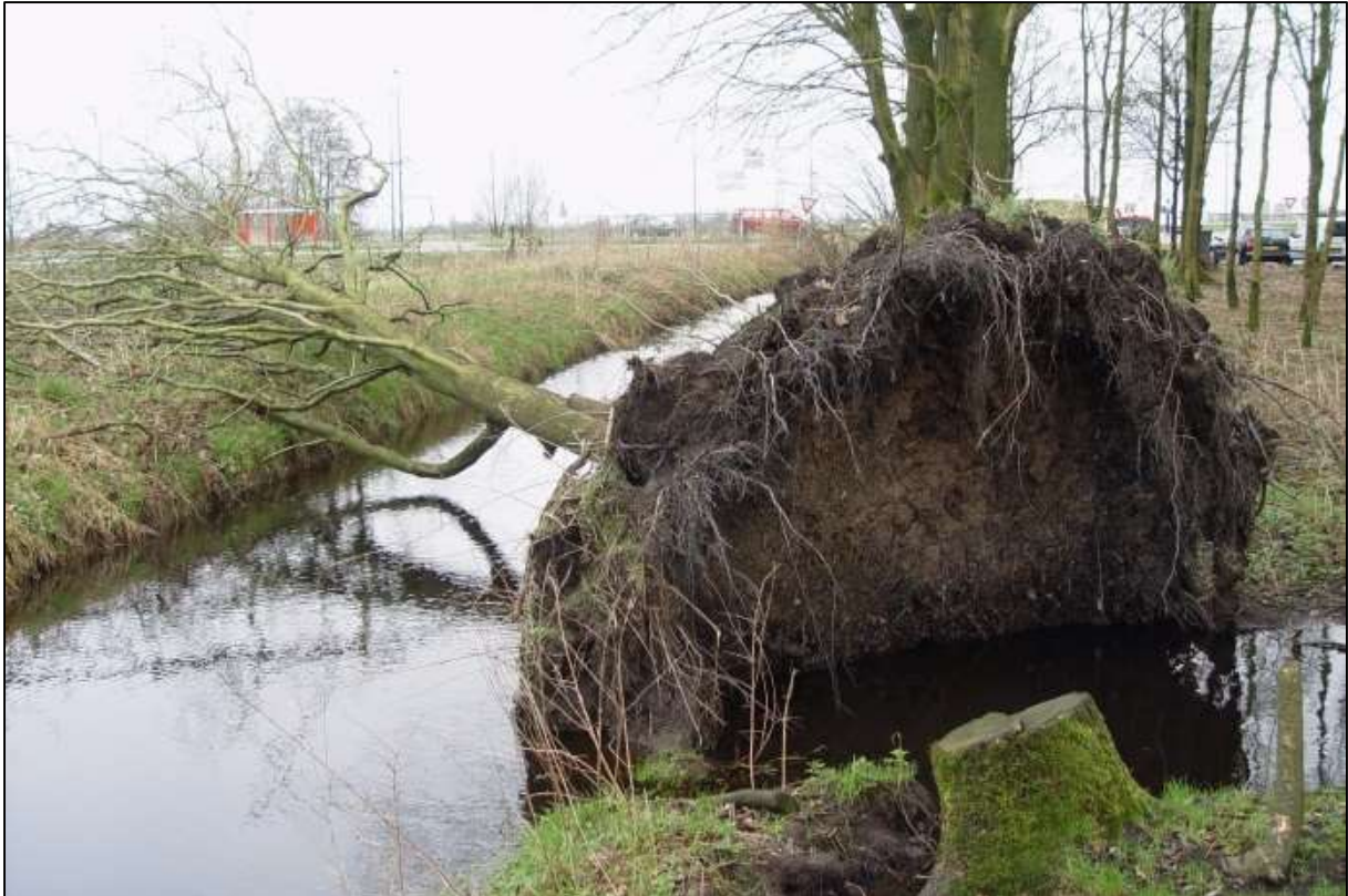
Figuur 12 Voorbeeld van een ontgrondingskuil die een gat in de dijk heeft veroorzaakt (Bron: Bomenwacht, 2019).
