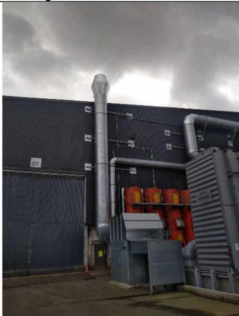
Foto 3 schoorsteen nieuwe systeem filter hal 7
