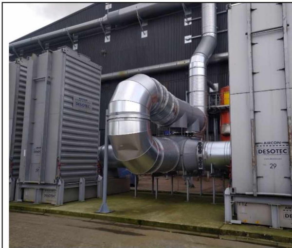
Foto 1 aanzuiglucht uit gebouw en verdeling over de 2 filterunits filter hal 7
