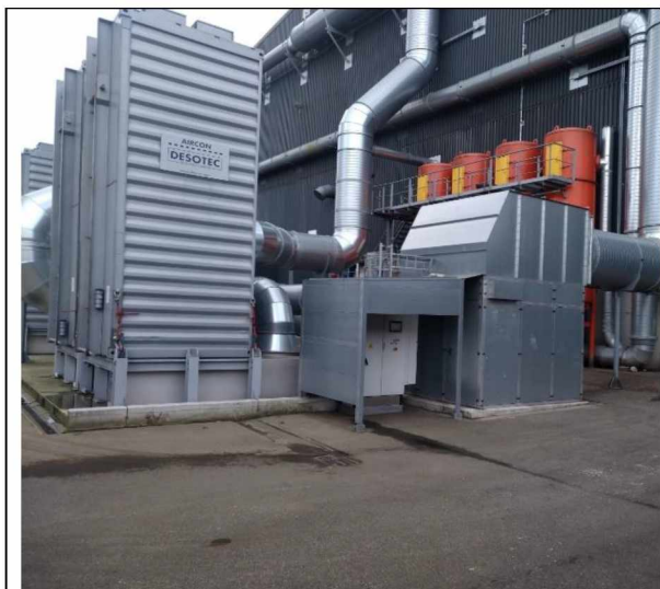
Foto 5, aanzicht van (geluids)geïsoleerde zuigtrek fan filter hal 7
