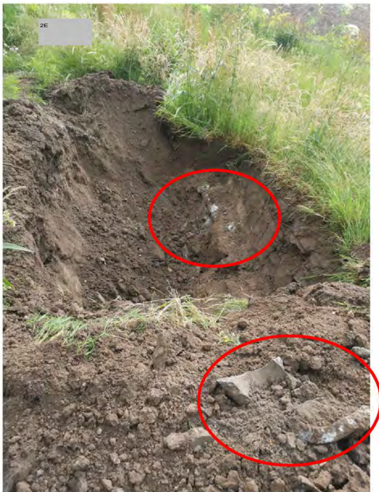
Asbesthoudend materiaal in depot
