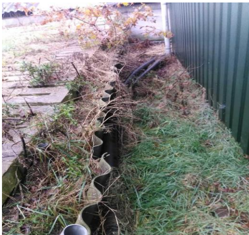
figuur 2: ingegraven asbestverdachte dakplaten
