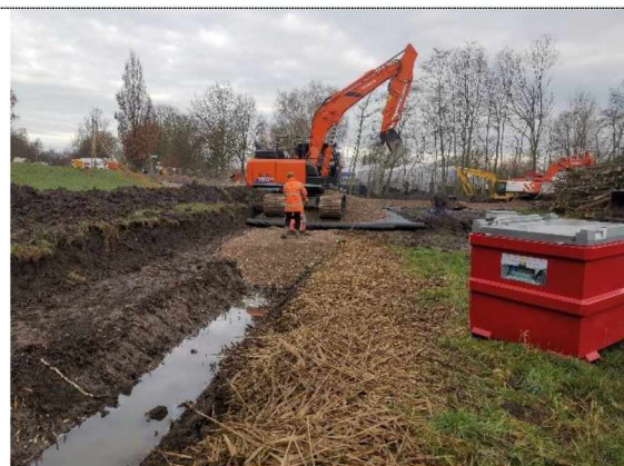
Foto 6: Aanleg parkeerplaats menggranulaat op doek
