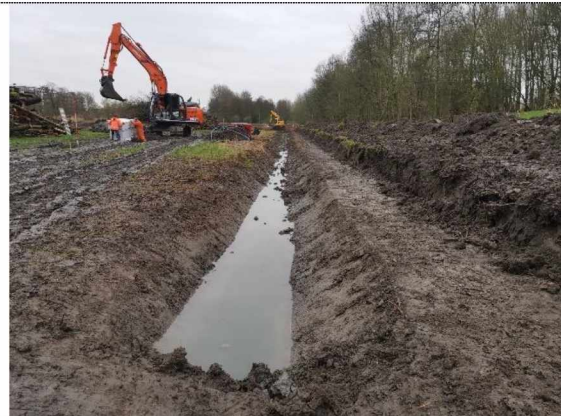
Foto 2: Kabel- en leidingsleuf
