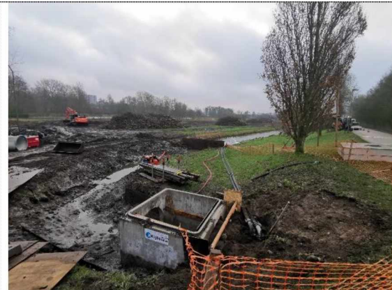
Foto 1: Start aanbrengen leeflaag 0,3 m
