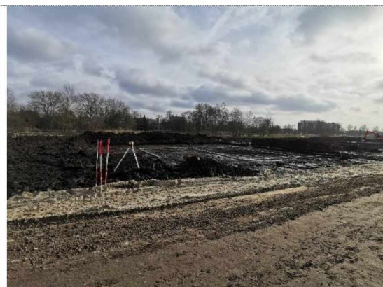
Foto 9: Plaatsing leeflaag grond 0,3 m
