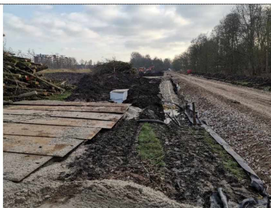
Foto 8: Aanvullen kabel- en leidingsleuf
