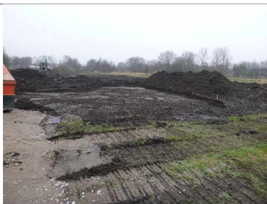
Foto 10: Plaatsing leeflaag grond 0,3 m
