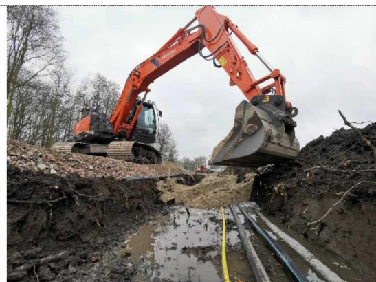
Foto 7: Aanvullen kabel- en leidingsleuf
