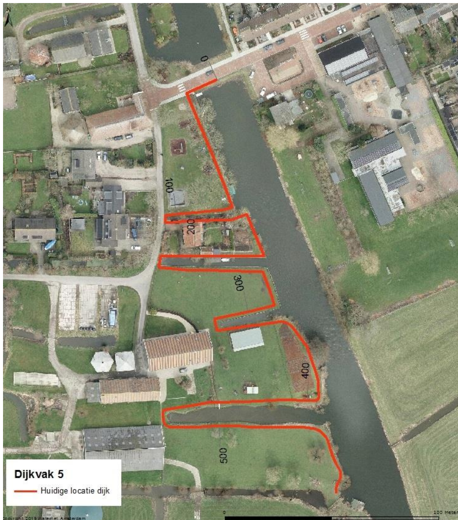
Figuur 25 Locatie dijkvak 5
