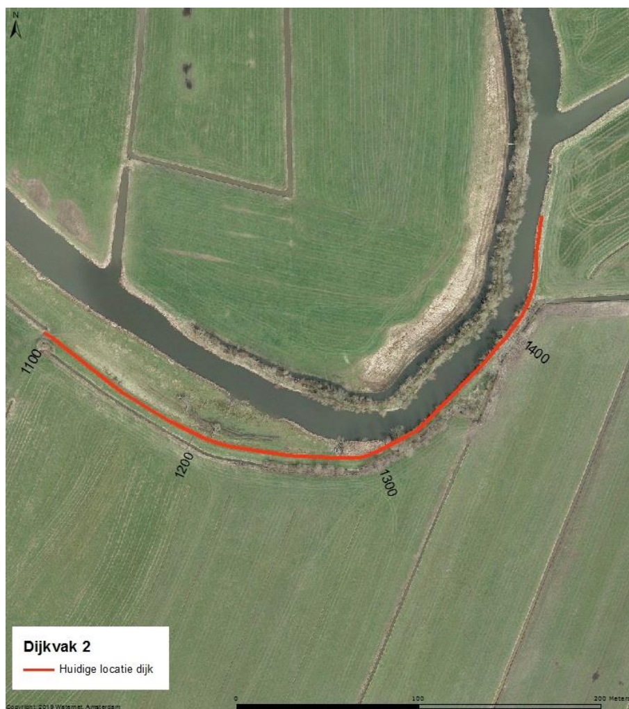
Figuur 11 Locatie dijkvak 2
