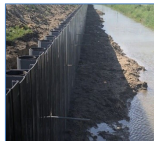
Figuur 6 Kunststof damwand Omega met stalen palen
