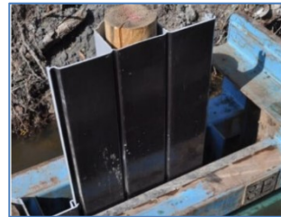
Figuur 4 Kunststof damwand Omega met houten palen
