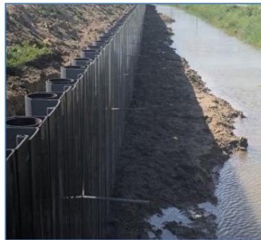
Figuur 4-6. Kunststof damwand met stalen buispalen
