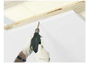
Focus F wordt met schroeven gemonleerd
