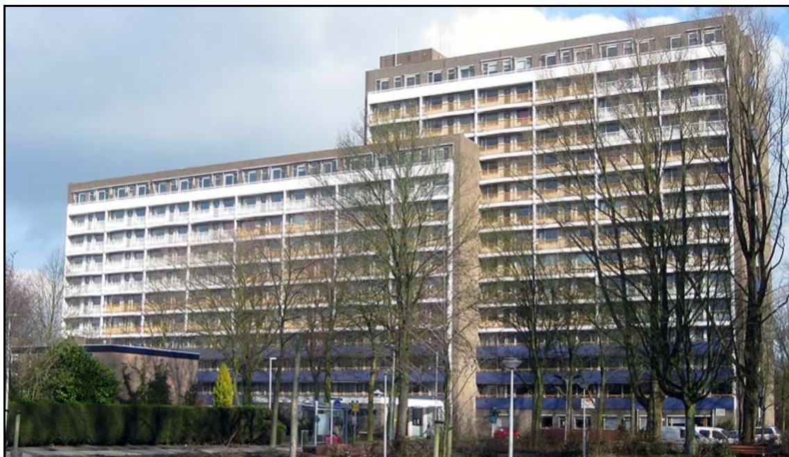
Afbeelding 3: Zicht op het in 2012 gesloopte Valckensteyn.
