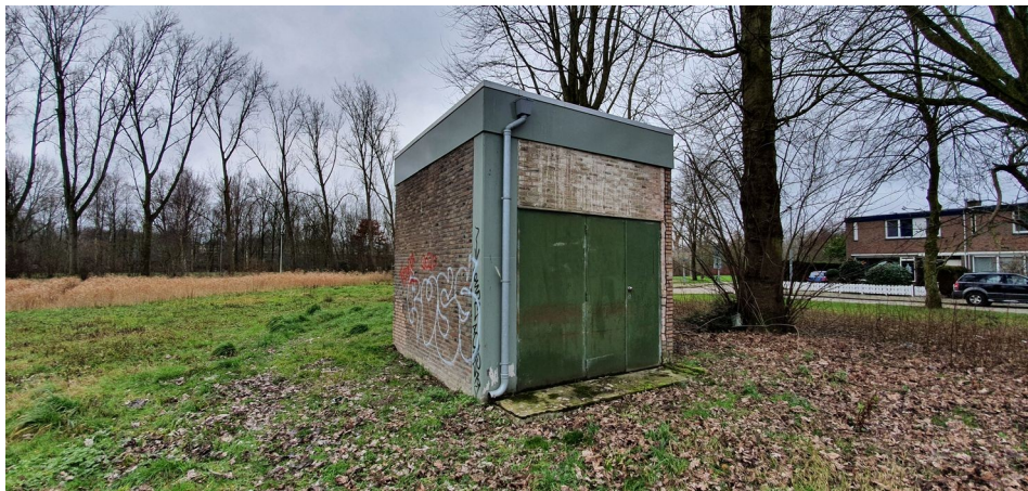
Het transformatorhuisje. Foto: K. de Vries | Ecoresult B.V.
