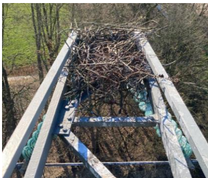
Figuur 1: Foto van een broedlocatie ooievaar op de hoogspanningsverbinding
