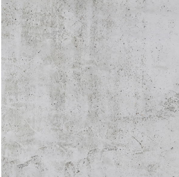
1 schoon beton: beplating in kist + nawerken + olie
