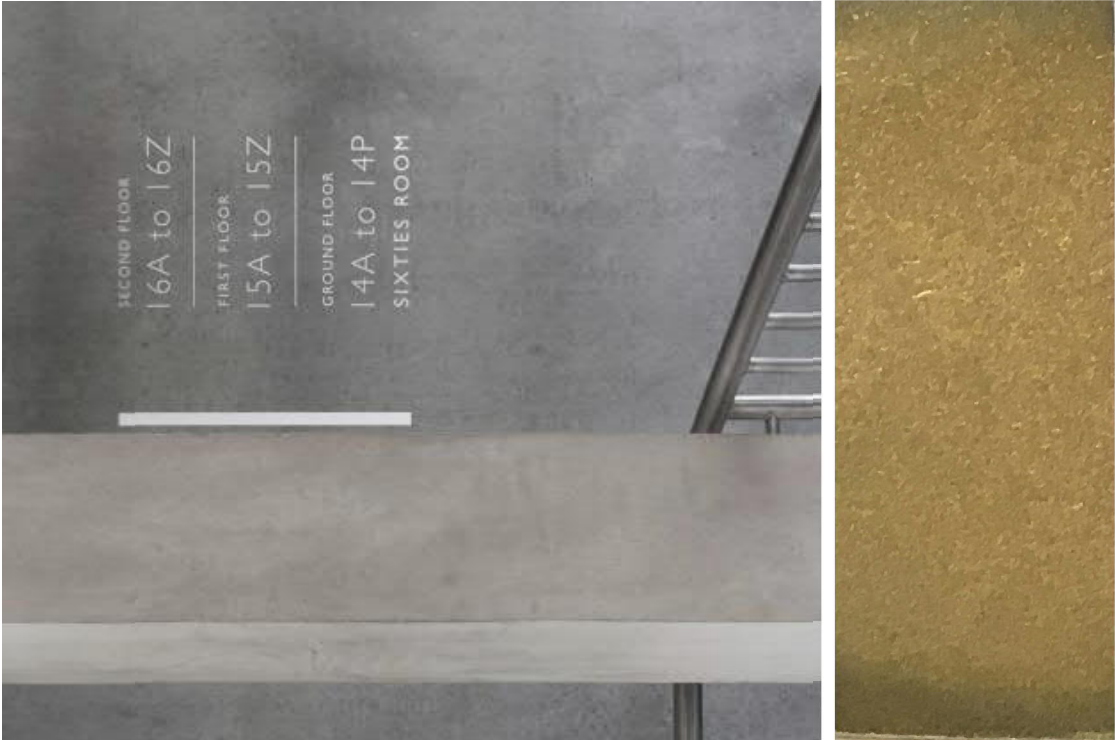
14 mat vinyl bewegwijzing plakt op betonnen wand kleur: pantone 871 U
