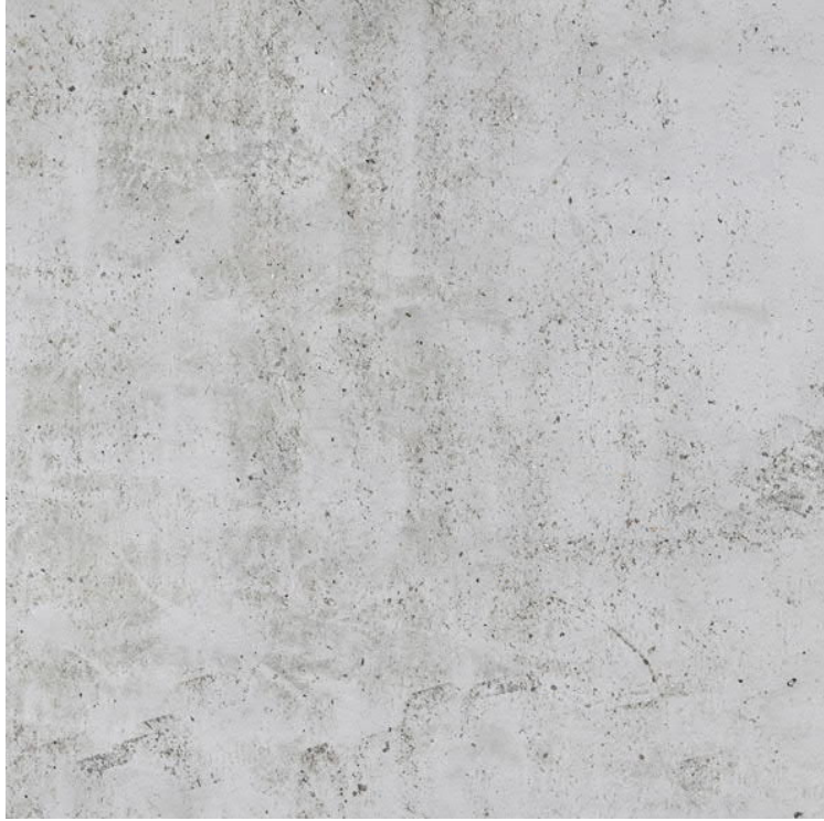
wand: schoon beton in zicht
