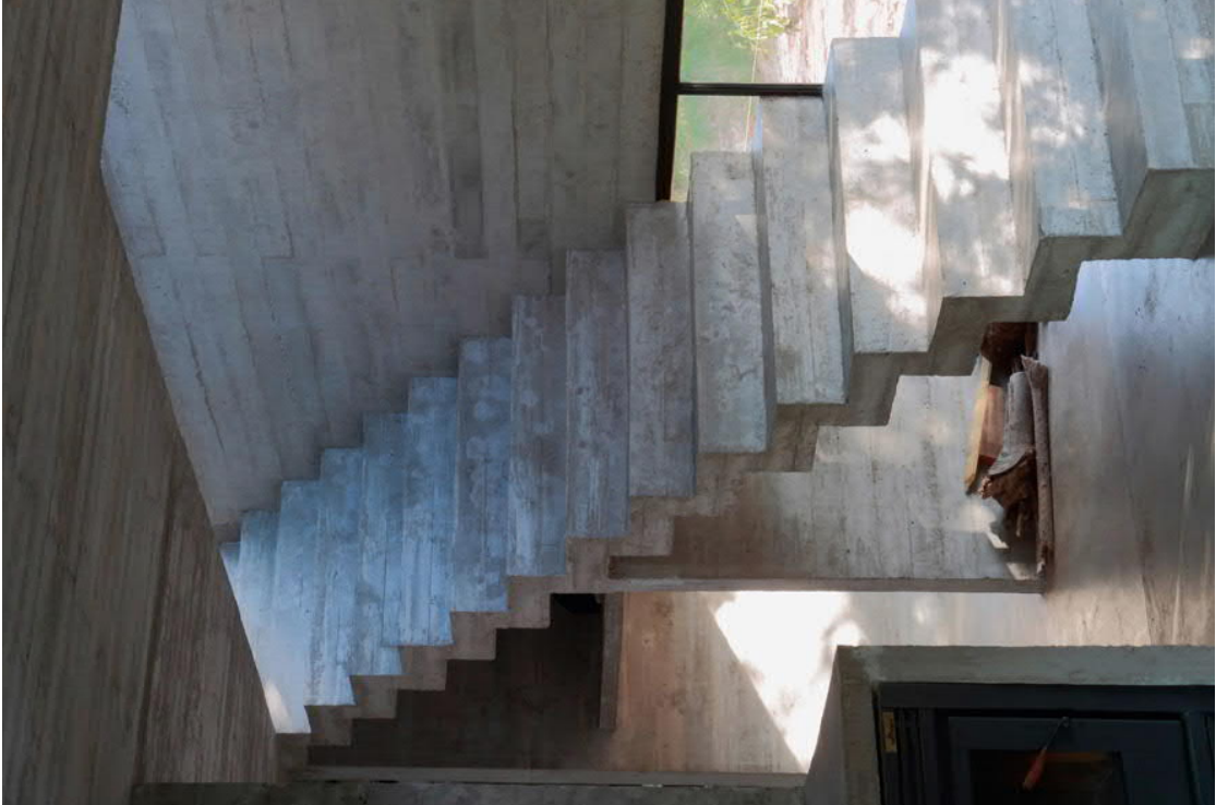
9 'in situ' betontrap
