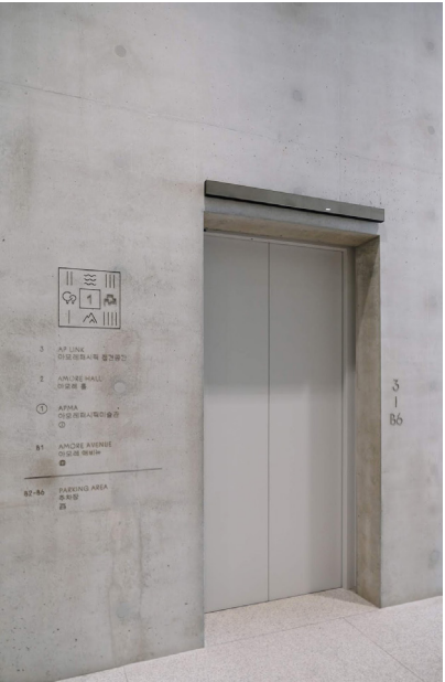
detail liftdeur terugliggend in de betonnen muur lift: Thyssenkrupp TWIN
