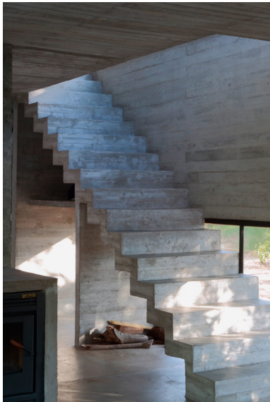
9 ‘in situ’ betontrap
