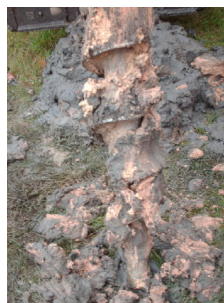
Foto links: Machinaal boren
