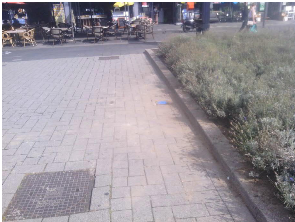
Foto 1: locatie peilbuis (westelijk deel)
