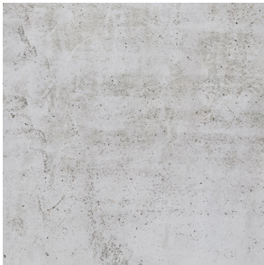
1 schoon beton: beplating in kist + nawerken + olie
