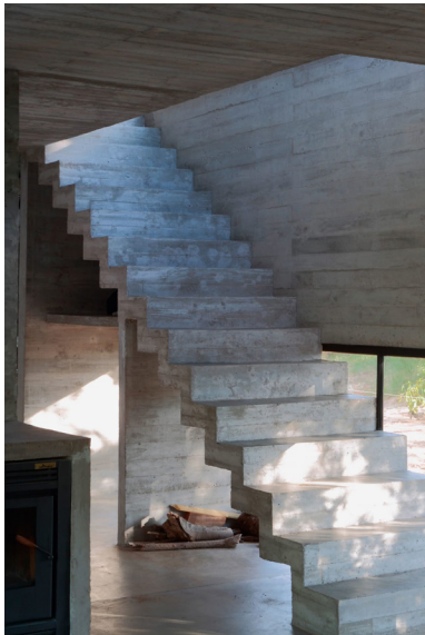
9 ‘in situ’ betontrap
