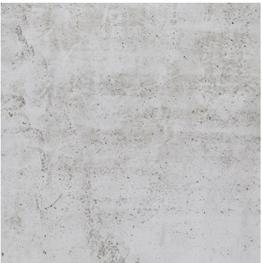
wand: schoon beton in zicht
