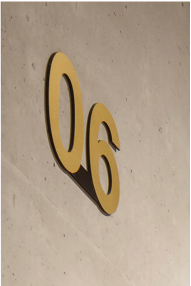
huisnummer: messing cijfers vast op de betonnen wand
