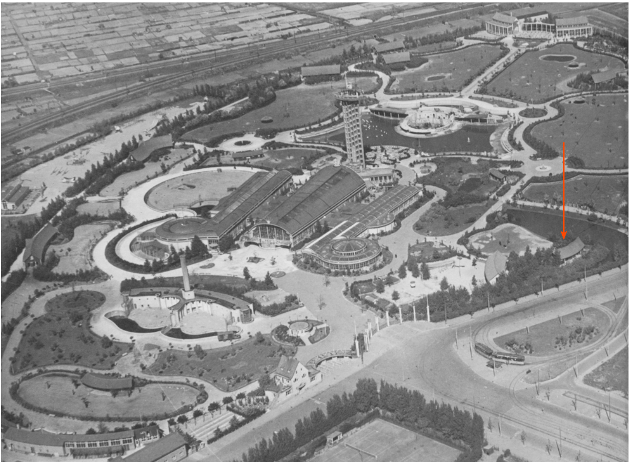
luchtfoto tussen 1943-1946 (foto: internet). Het nachtverblijf Y op zijn oorspronkelijke plek.
