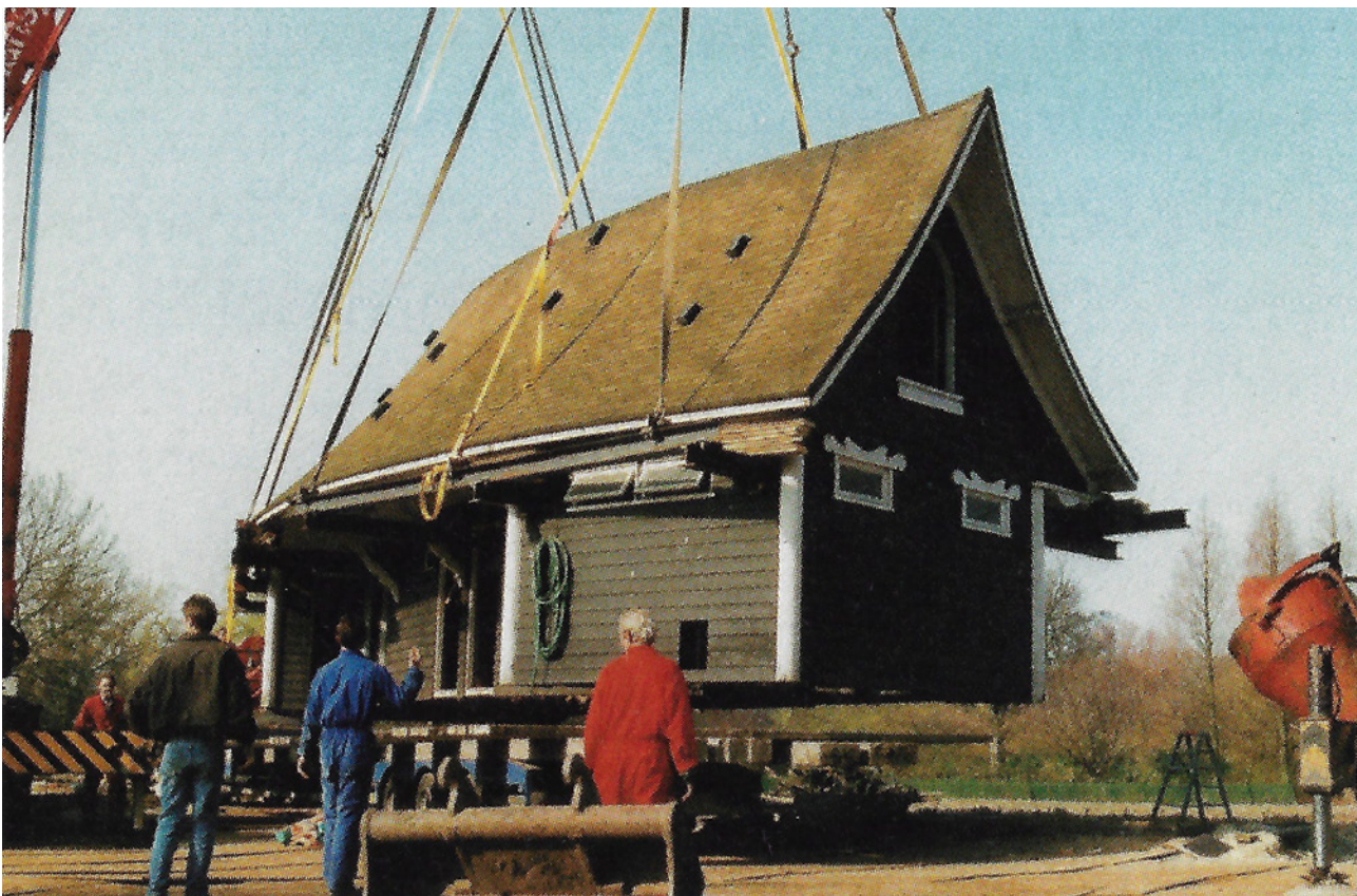
Verplaatsing van gebouw Y in 1996-1997 om plaats te maken voor het Aziëhuis (foto: DB). Het gebouw is in zijn geheel van de fundering getild en op een nieuwe daartoe gemaakte fundering verderop geplaatst. Bij de eerste verplaatsing is het gebouw ook in zijn geheel verplaatst.
