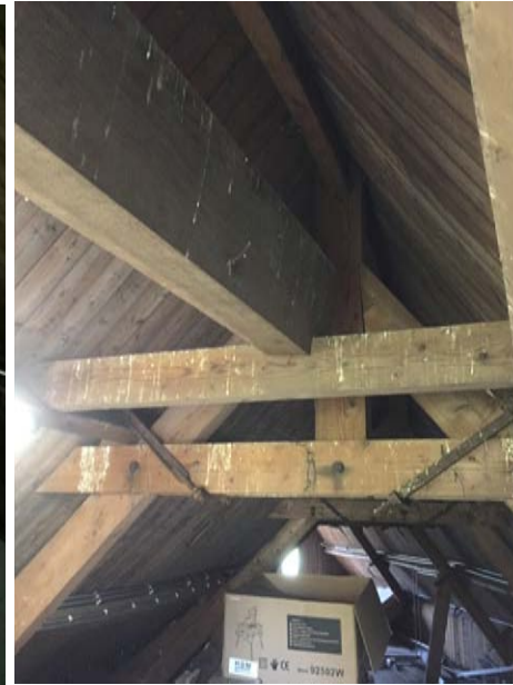
foto hijsbalk zonder spantverankering
