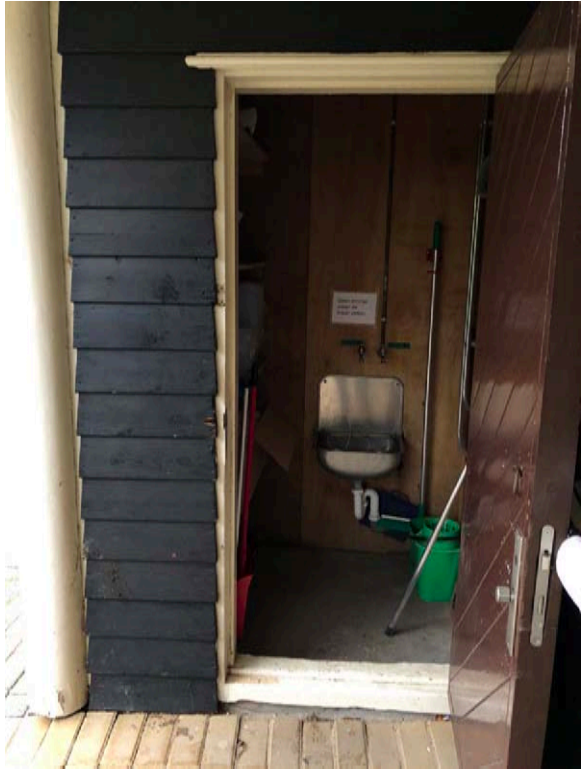
foto berging in voorgevel
