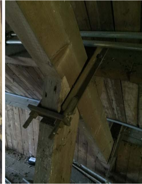
foto roestig spantanker
