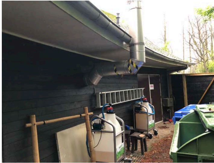
Overzichtsfoto achtergevel rechts
