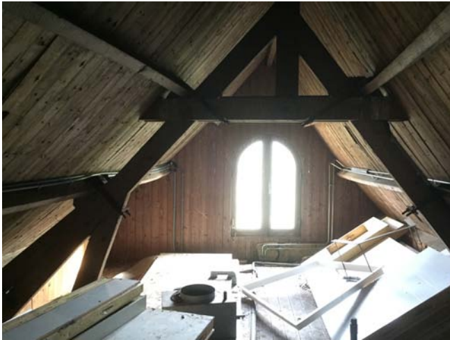
foto zolder met asymmetrische spantconstructie
