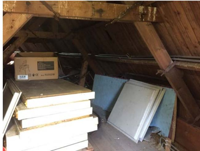
foto spant en licht doorgebogen spanten + inventaris
