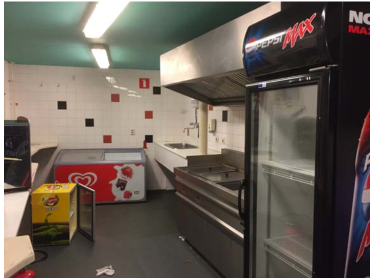
foto keuken richting linkerzijgevel
