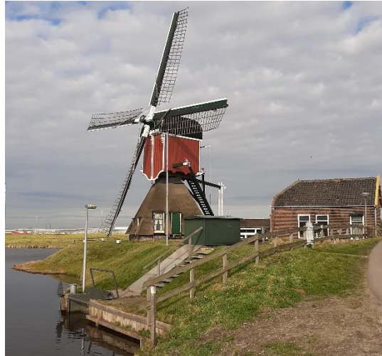
Afbeelding 5 Poldergemaal Hoogmade – foto huidige situatie
