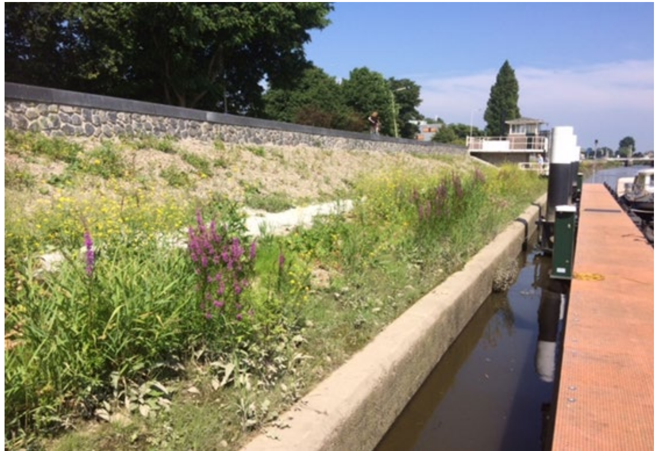
Figuur B4- 7 Een deel van de in 2018 versterkte Goejanverwelledijk. Bij de versterking heeft de primaire kering een multifunctioneel karakter gekregen. Zo zie je dat de dijk zo laag mogelijk is gehouden en er een natuurstenen muur is gemaakt voor het behoud van een mooi aanzicht, er een aanlegplek voor vaarverkeer en een struinpad zijn aangelegd en wilde bloemen zijn geplant.
