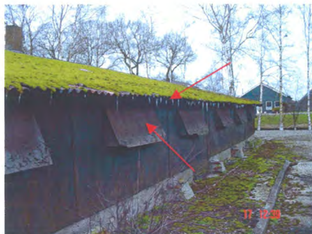
Foto 4: Dak en ventilatie openingen asbesthoudend
