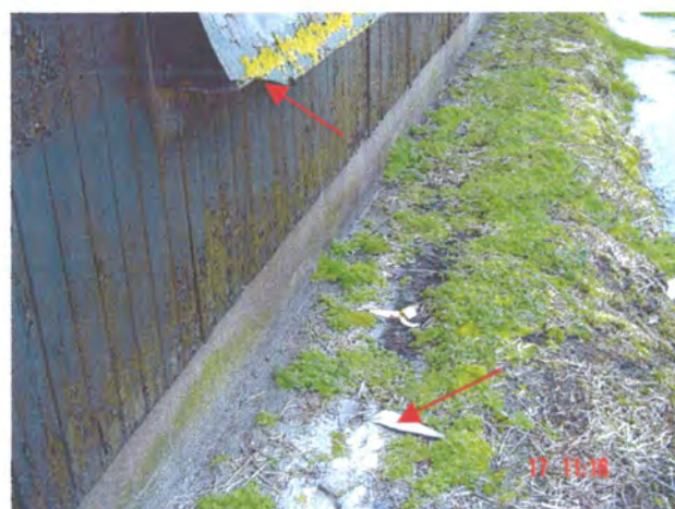
Foto 6: Plaat ventilatieopening beschadigd
