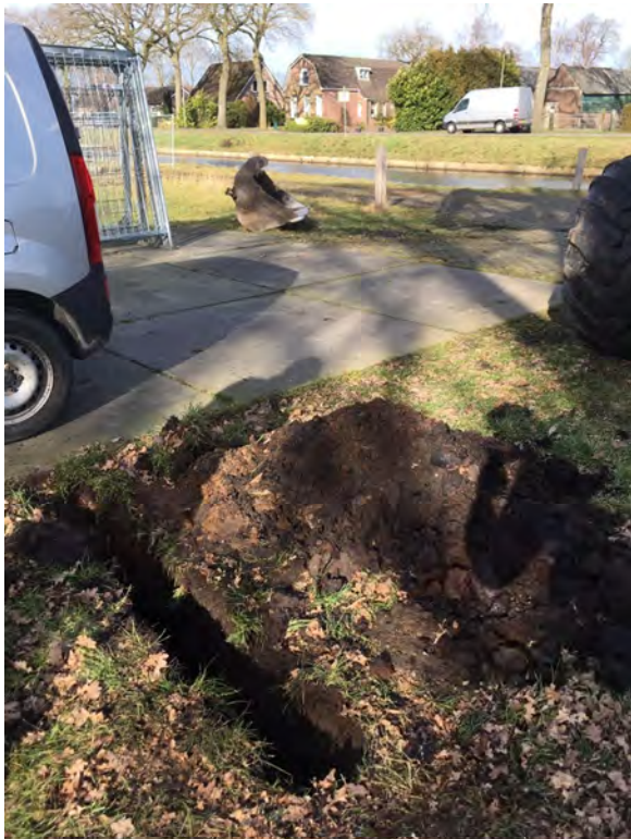
Geen bodemvreemde bijmengingen onder/naast stelconplaat bij de brug
