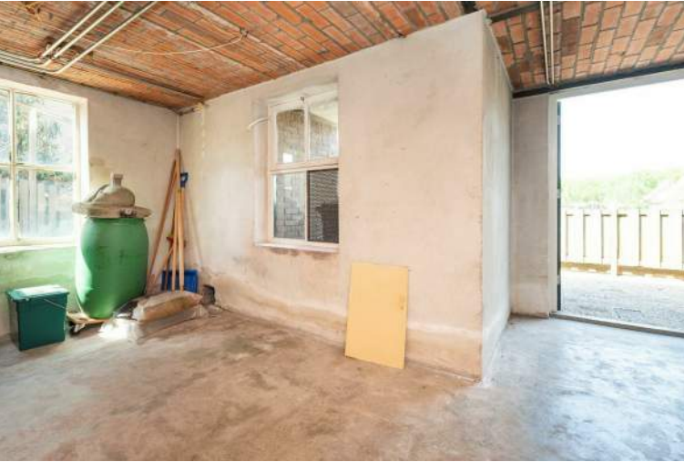
Souterrain met te verwijderen draagmuren en NeHoBo vloer, foto richting achtergevel
