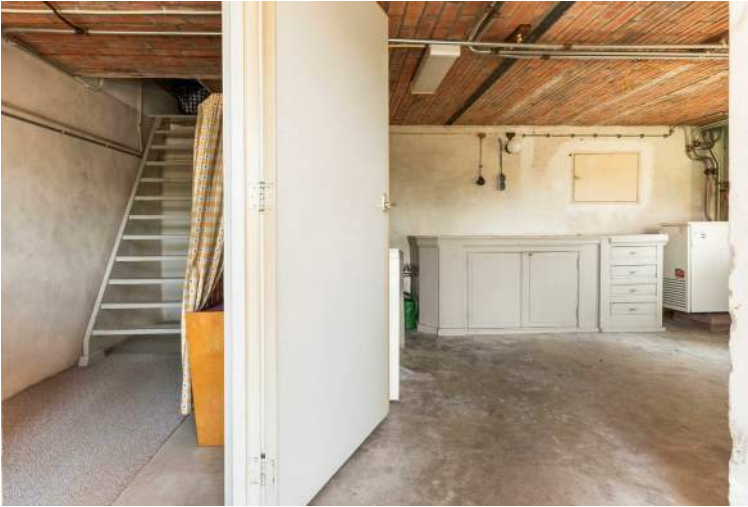
Souterrain met te verwijderen draagmuren en NeHoBo vloer, foto richting voorgevel
