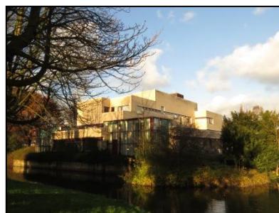
Figuur 4. Zicht noordwaarts vanaf Sir Winston Churchillaan op het pand.
